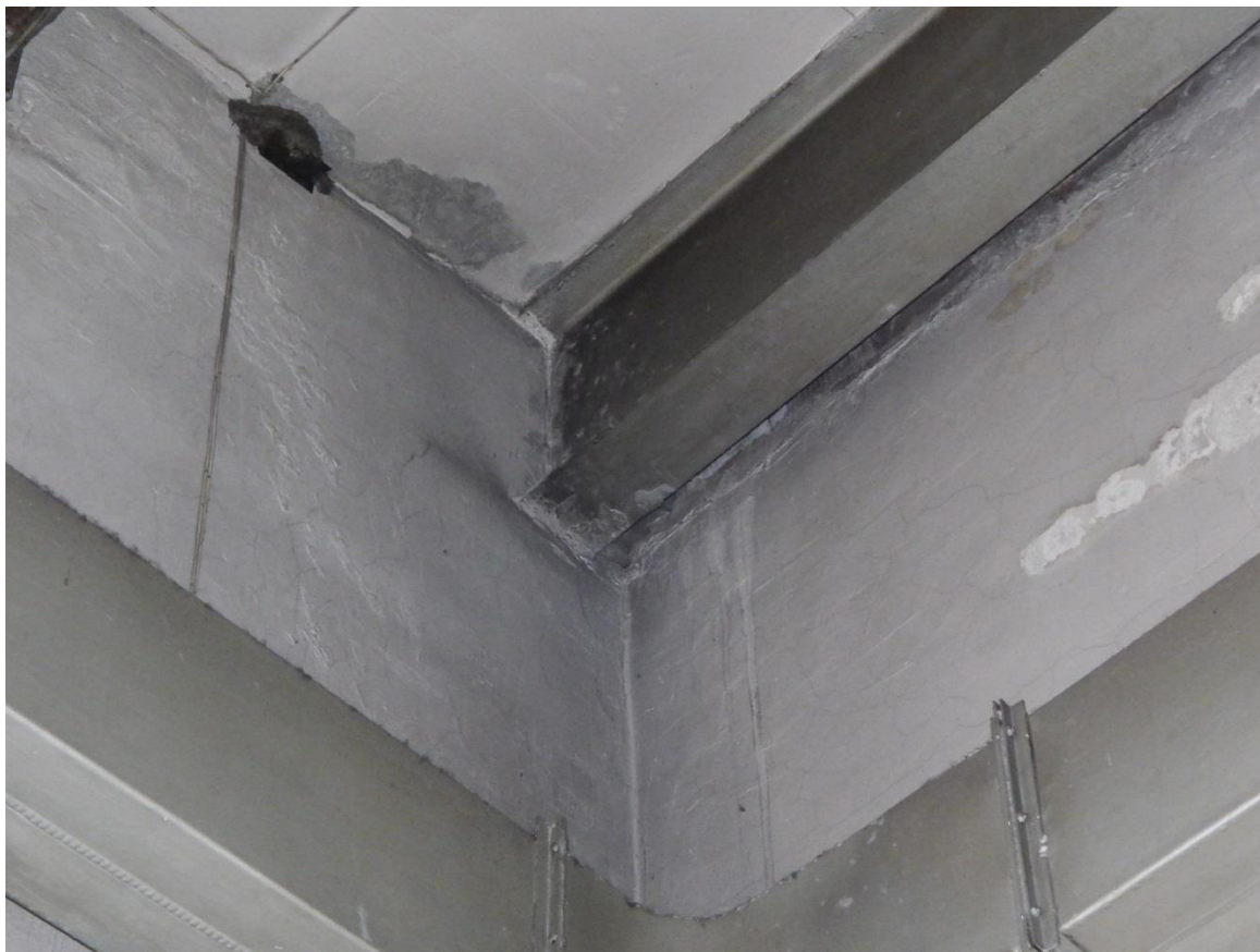
Рис. 3.2.15. Внешний вид узла опирания стальной балки, выполненной из оди- нарного прокатного двутавра 60Б1 на кирпичную стену
