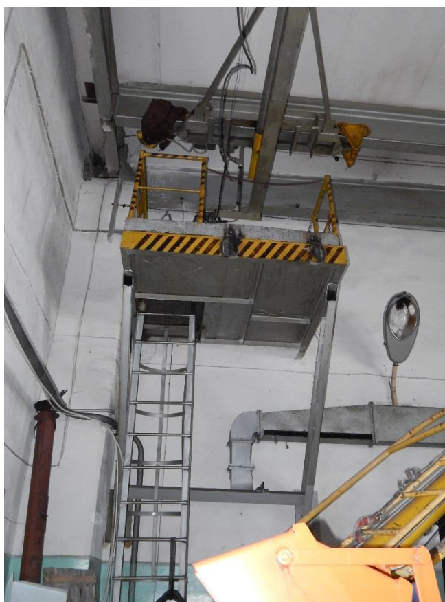
Рис. 3.8.3. Внешний вид площадки обслуживания кран-балки по стене, расположенной по оси 3
