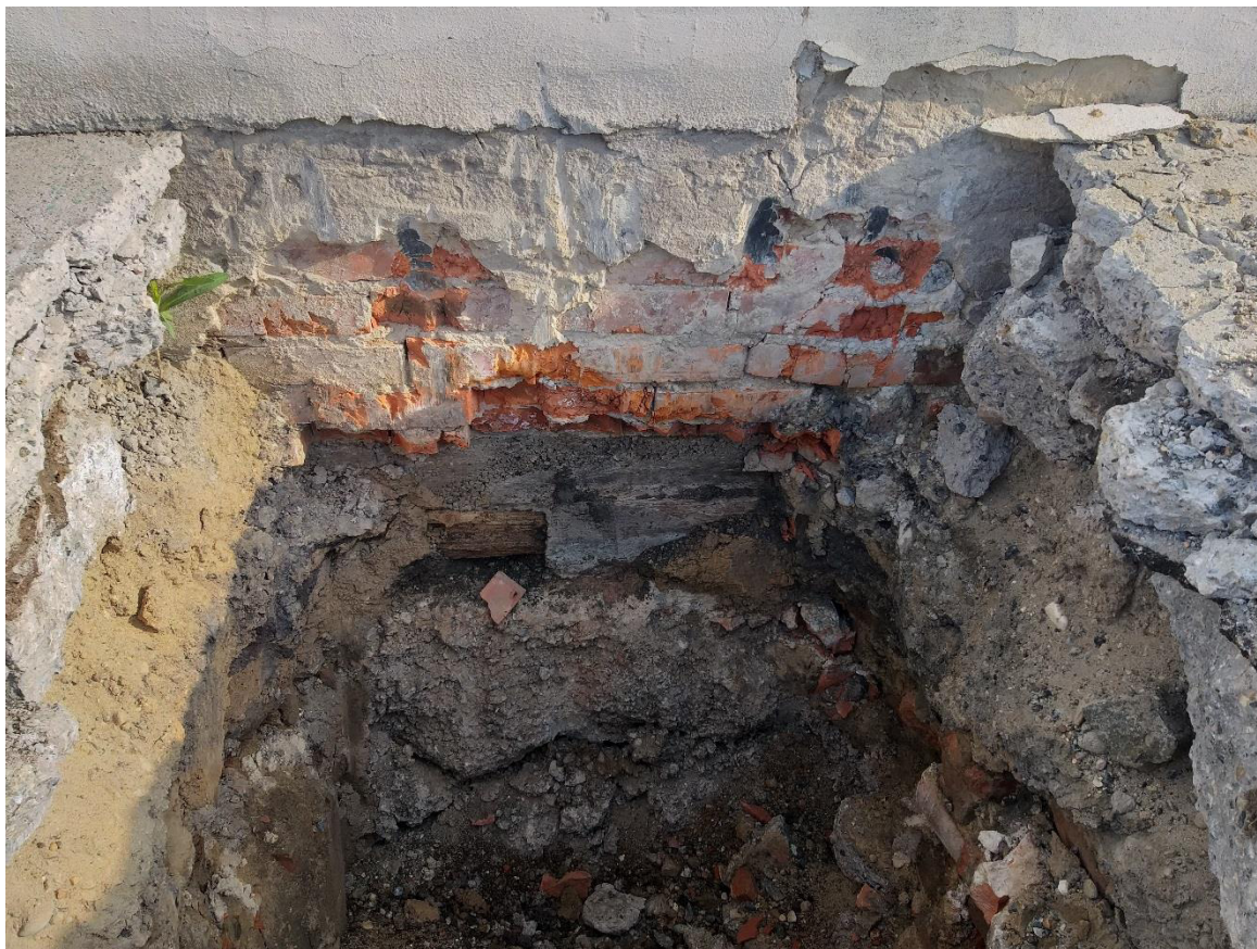
Рис. 3.7.11. Внешний вид шурфа №2. Кирпичный цоколь расположен ниже отметки земли на 450 мм
