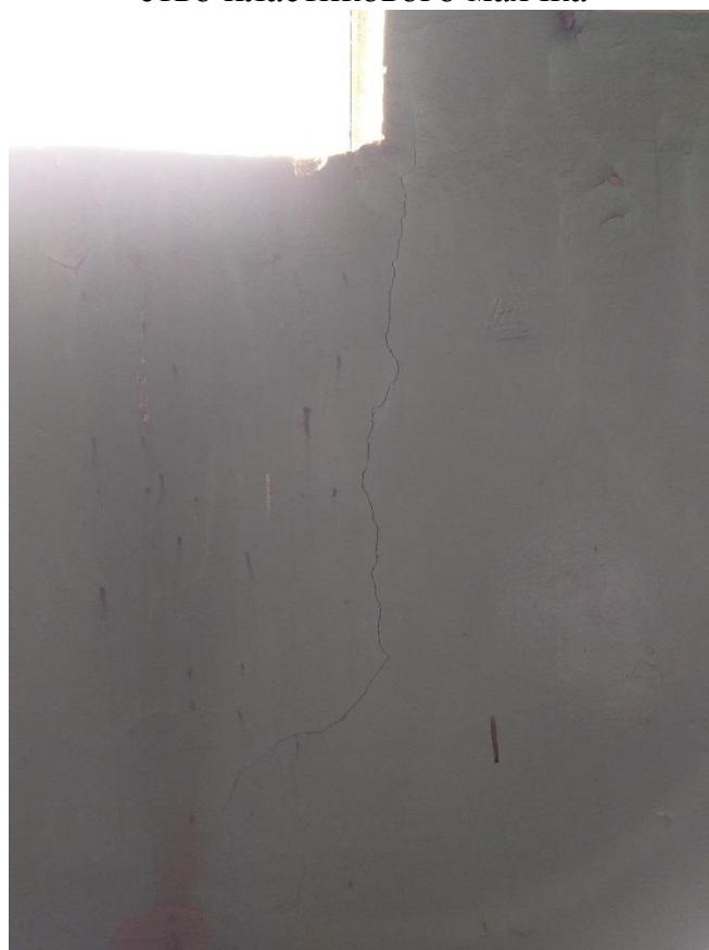
Рис. 3.1.31. Трещина №20 шириной раскрытия до 0,5 мм (вид изнутри)
