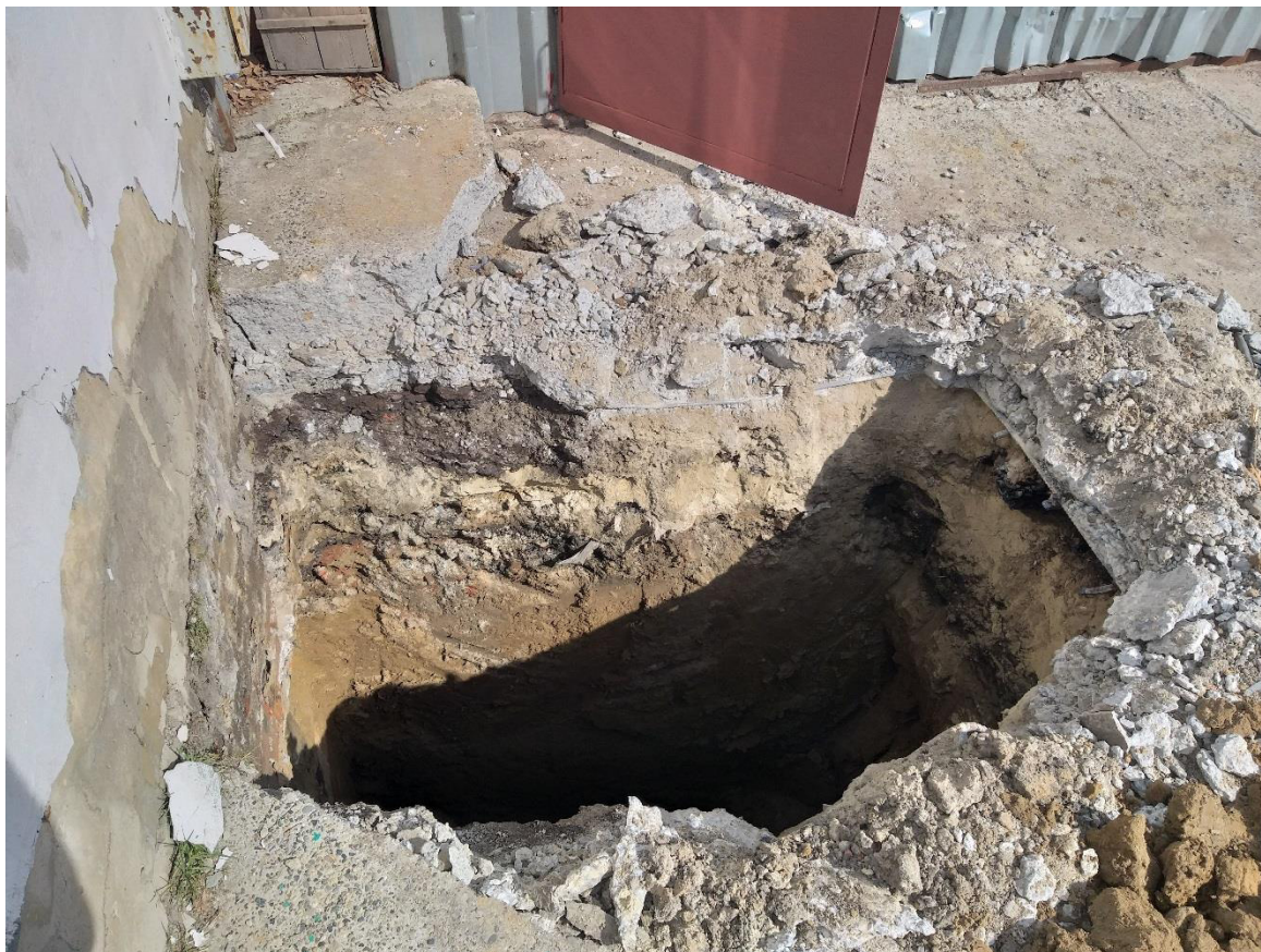
Рис. 3.7.5. Внешний вид шурфа №1
