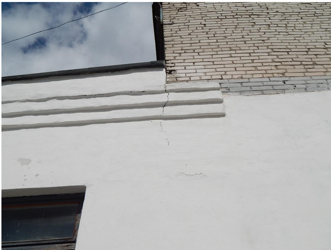
Рис. 3.1.3. Трещина №2 шириной раскрытия до 0,5 мм (вид с улицы)
