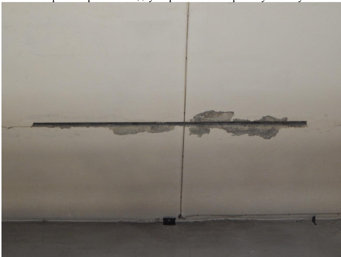
Рис. 3.2.16. Дефект в виде выпадения раствора из межплитных швов в помеще- нии гаража
