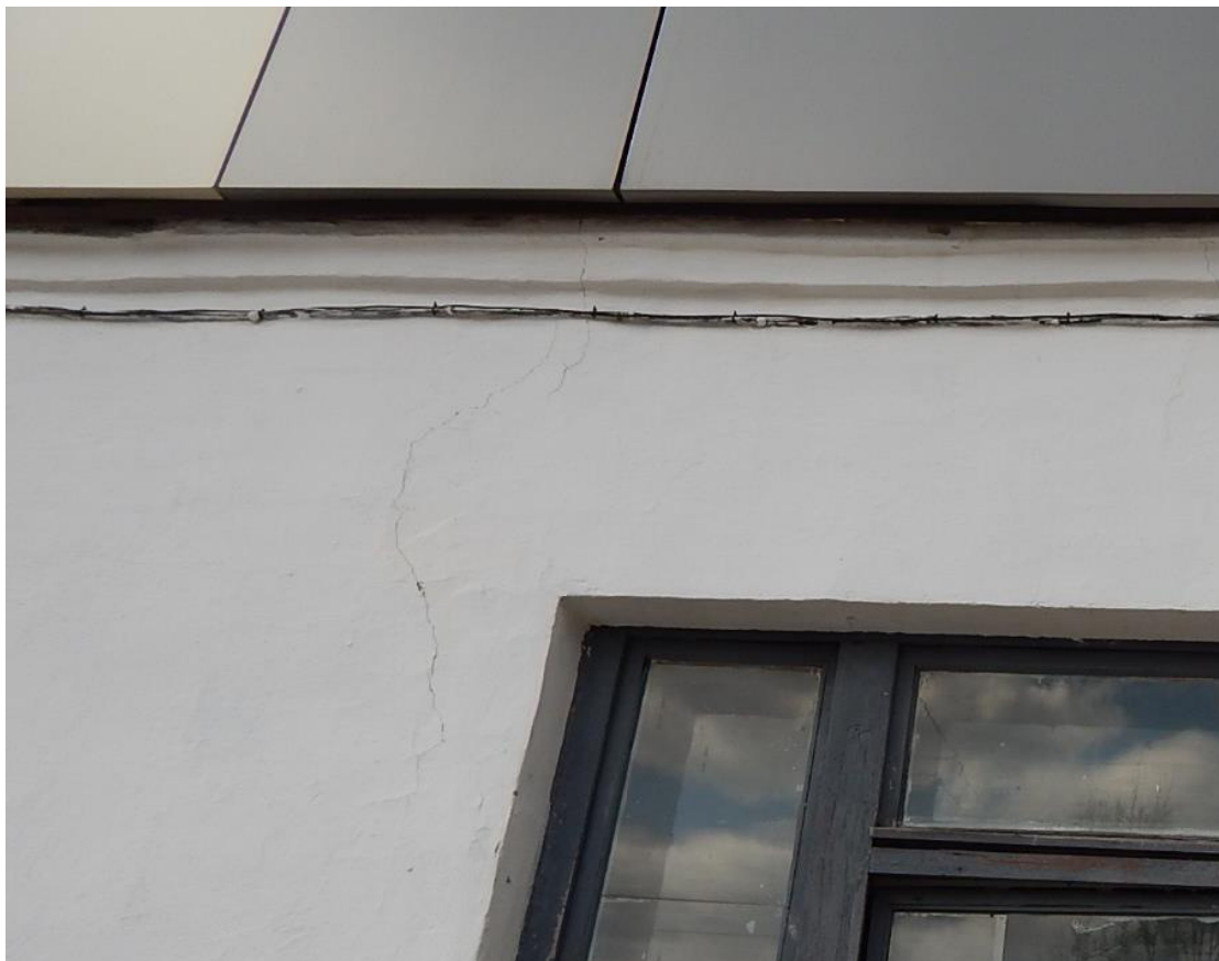
Рис. 3.1.16. Трещина №13 шириной раскрытия до 0,5 мм (вид с улицы)
