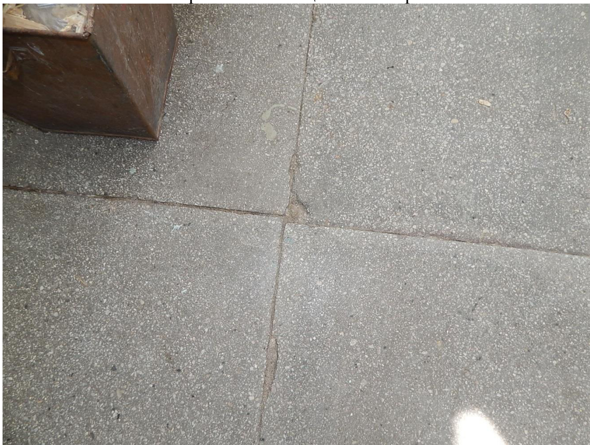
Рис. 3.5.14. Дефект в виде мелких сколов бетонных плит с добавлением мраморной крошки в помещении мастерской
