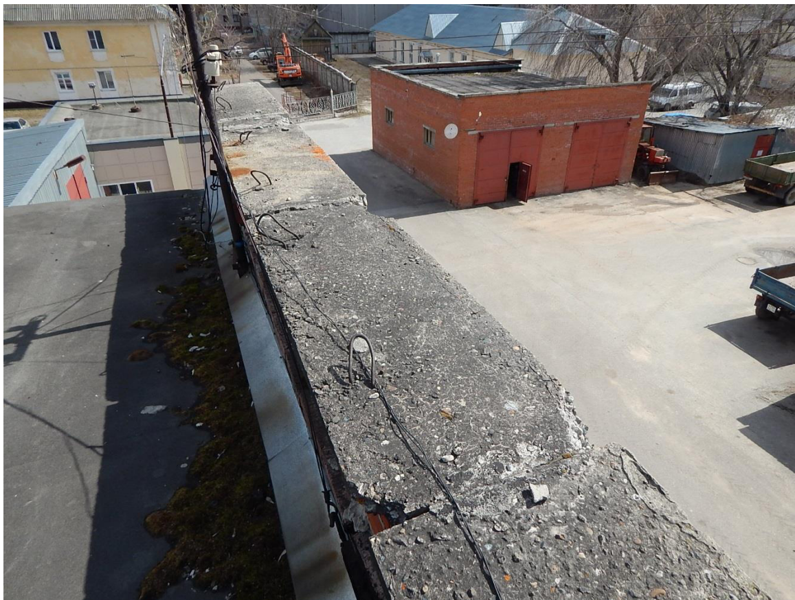
Рис. 3.3.9. Раскрашивание, разрушение бетона железобетонных парапетных плит
