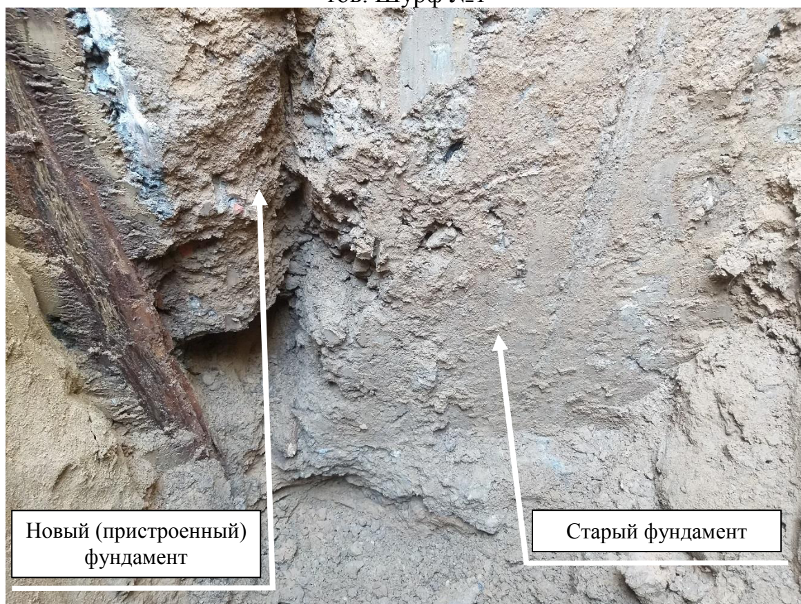
Рис. 3.7.8. Выявлено отсутствие уширения нижней опорной части пристроенного фундамента. Шурф №1
