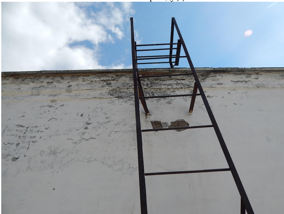
Рис. 3.1.37. Дефект в виде следов замачивания локального участка наружной стены по фасаду Д-А
