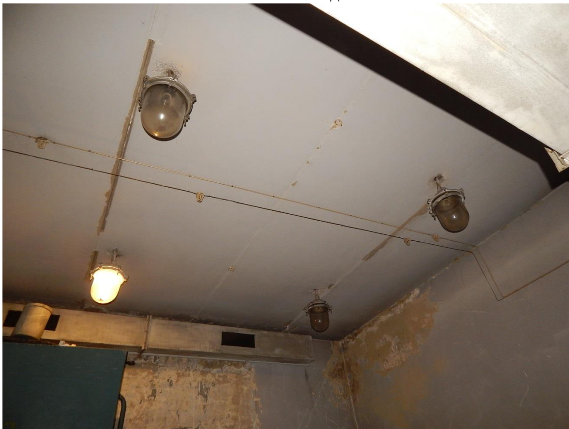
Рис. 3.2.20. Дефект в виде выпадения раствора из межплитных швов в помещении регенерационной
