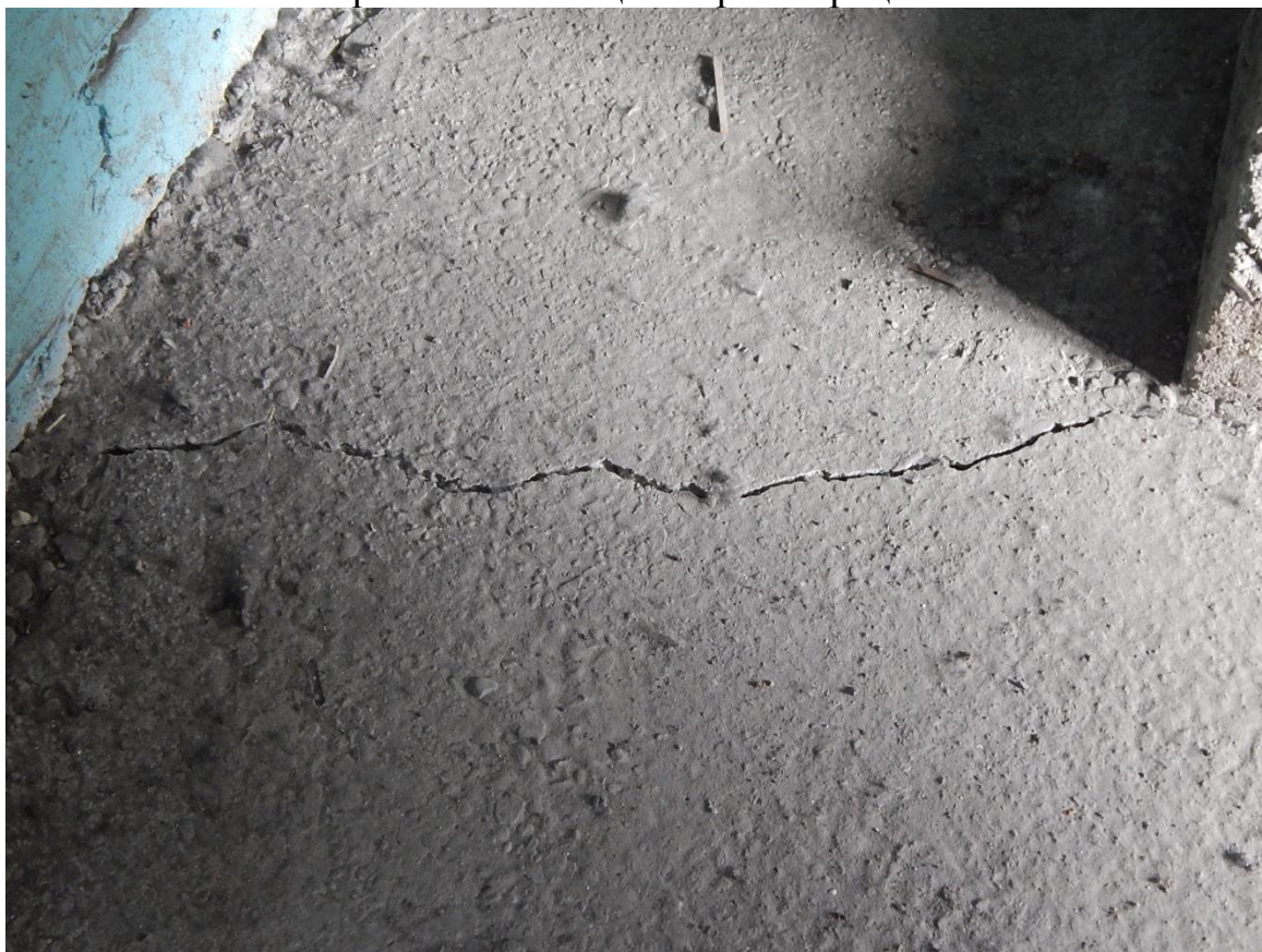
Рис. 3.5.16. Дефект в виде трещин в бетонном полу в помещении вентиляционной
