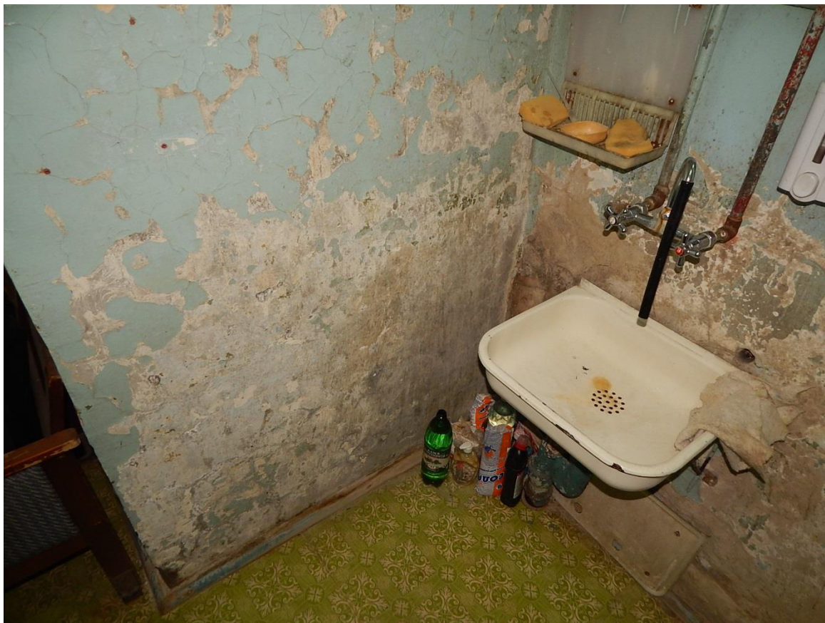
Рис. 3.1.44. Дефект в виде локального разрушения штукатурного слоя внутренней отделки стен
