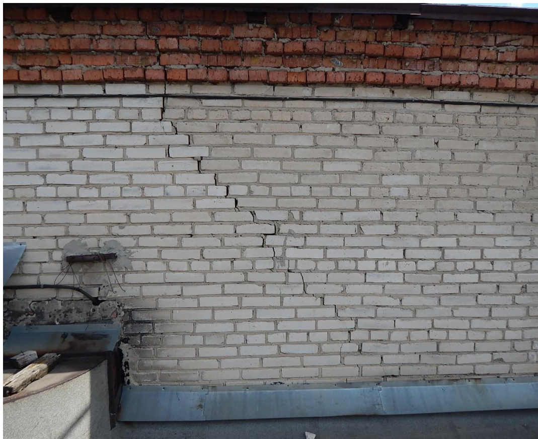
Рис. 3.1.12. Трещина №10 шириной раскрытия до 5 мм (вид с улицы)
