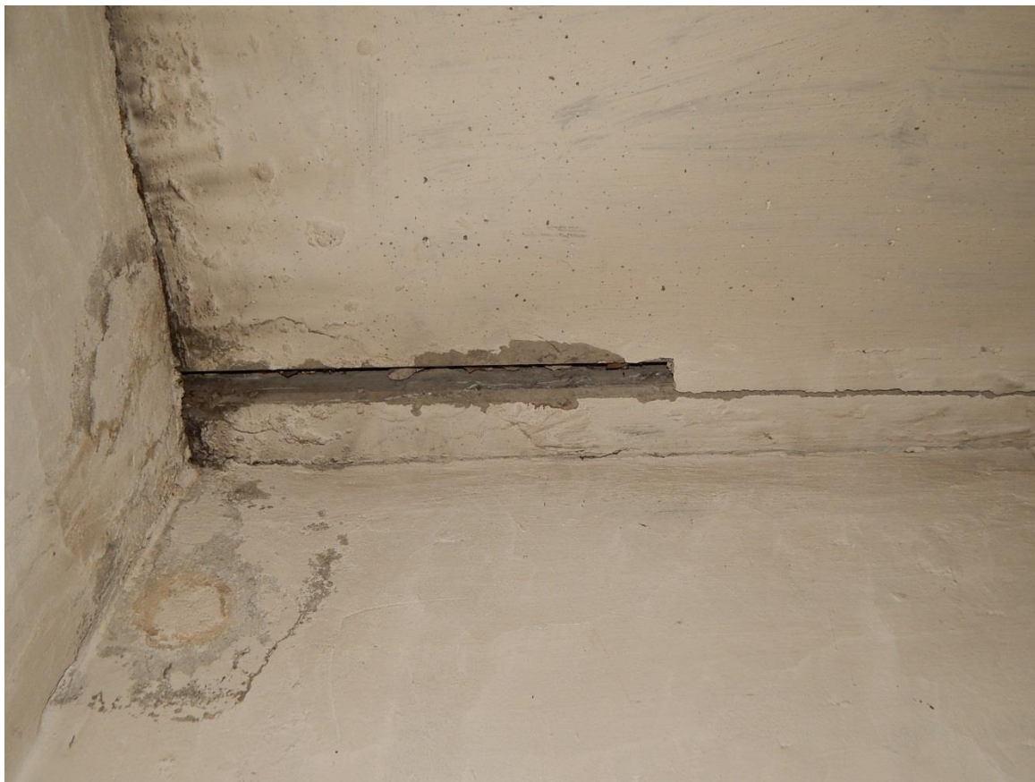
Рис. 3.2.21. Дефект в виде выпадения раствора из межплитных швов в вентка- мере
