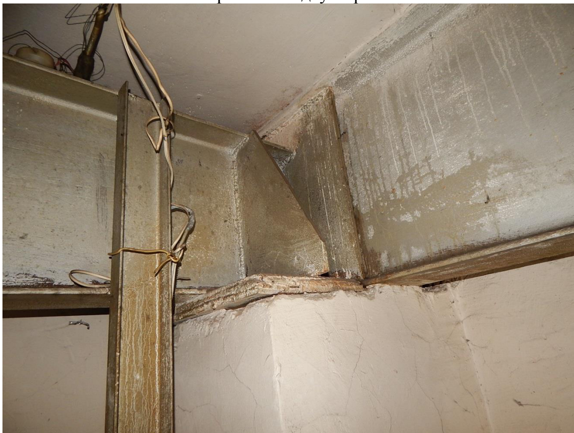
Рис. 3.2.14. Внешний вид узла опирания стальной балки, выполненной из одинарного прокатного двутавра 60Б1 на кирпичную пилястру
