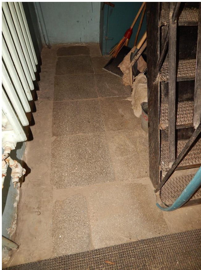
Рис. 3.5.5. Внешний вид пола с покрытием из бетонных плит с добавлением мраморной крошки на лестничной клетке 1-го этажа
