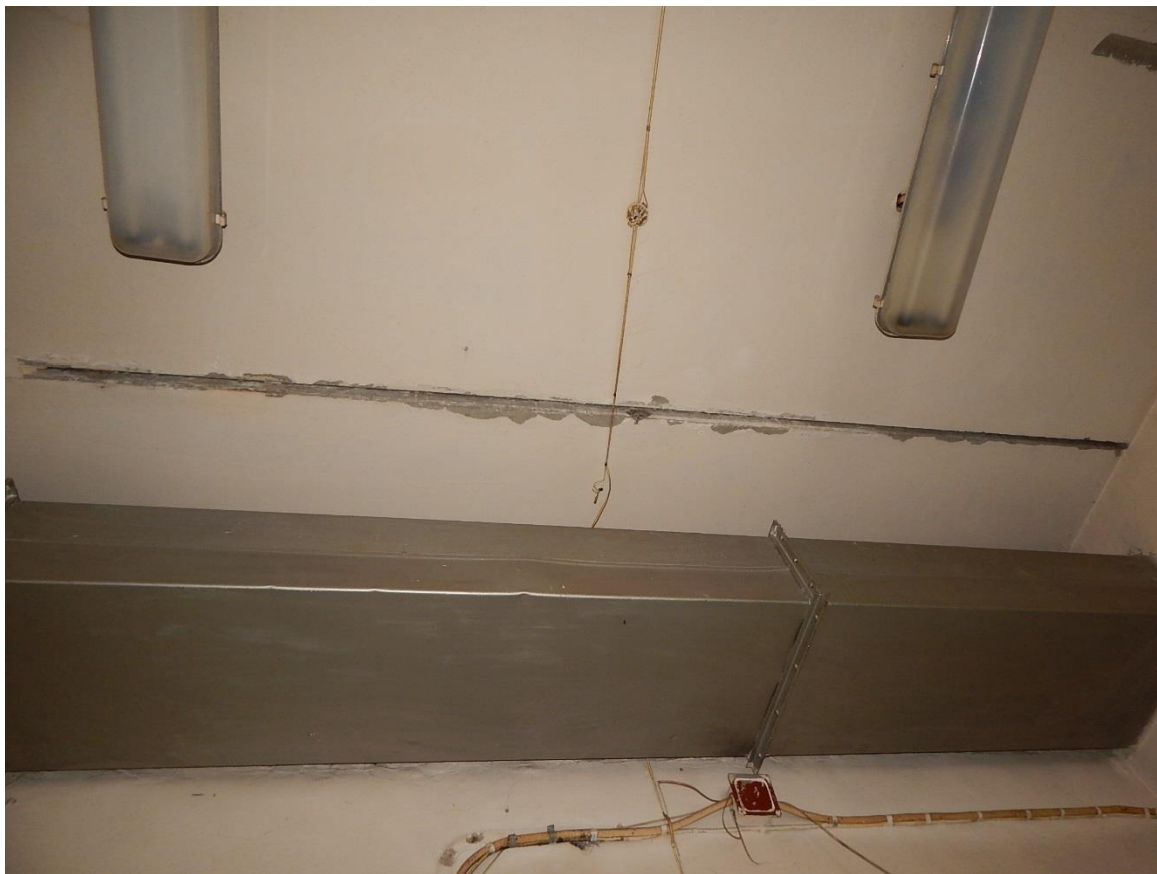
Рис. 3.2.19. Дефект в виде выпадения раствора из межплитных швов в помещении комнаты отдыха
