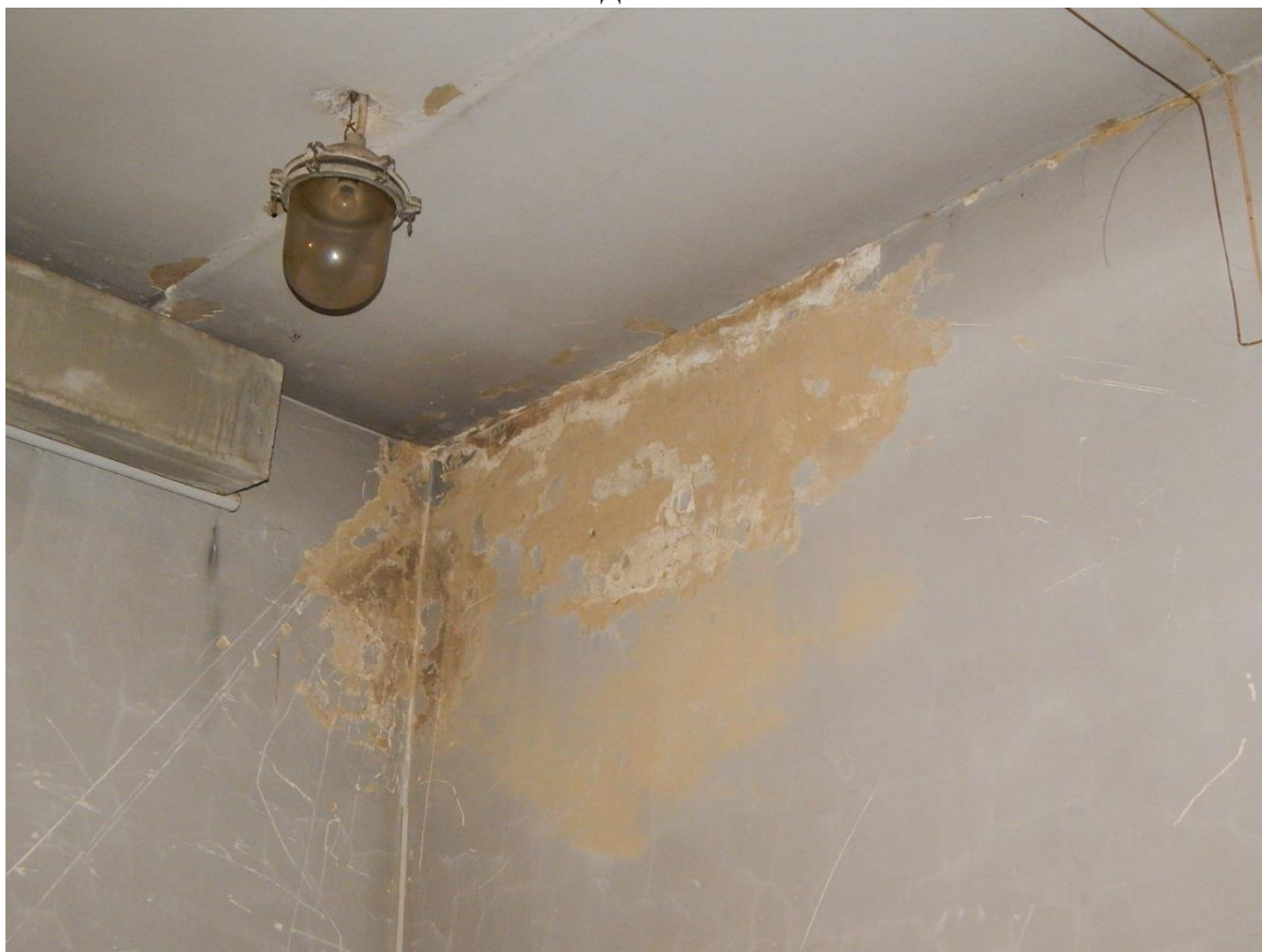
Рис. 3.1.47. Дефект в виде локального разрушения штукатурного слоя внутренней отделки стен
