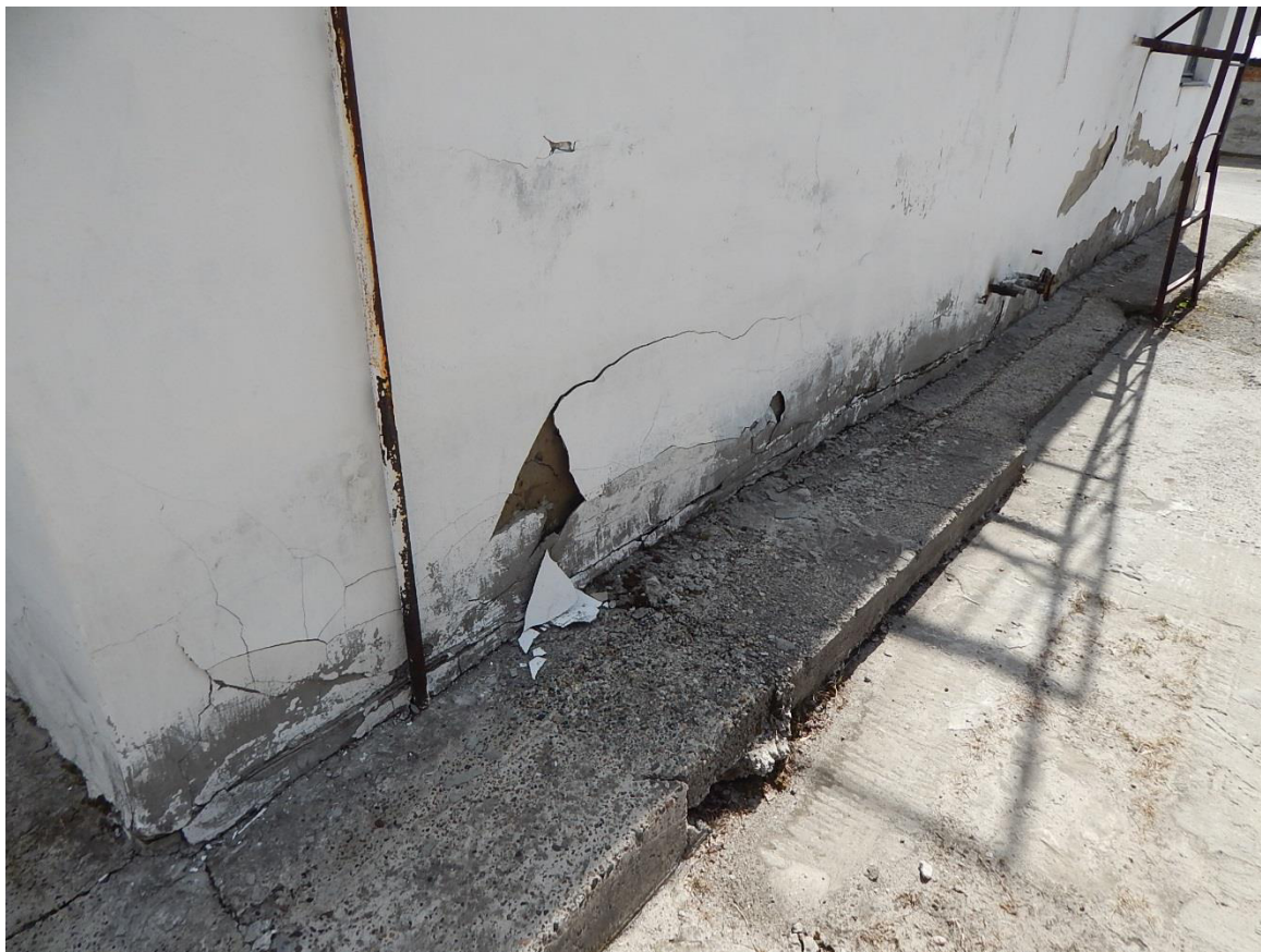
Рис. 3.1.36. Дефект в виде отслоения штукатурного слоя от поверхности наружной стены по фасаду Д-А
