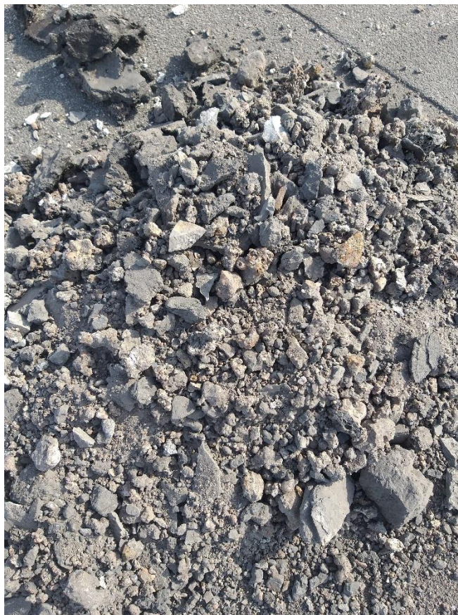
Рис. 3.3.5. Внешний шлаковой засыпки, выполняющей роль утеплителя «старой» кровли на участке в осях А-Д/2-4 (участок №1)
