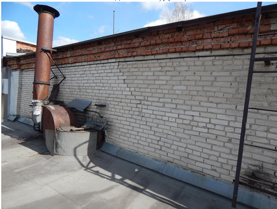
Рис. 3.3.18. Недостаточная величина вылета кровельного свеса, расположенного по стене вдоль оси 2
