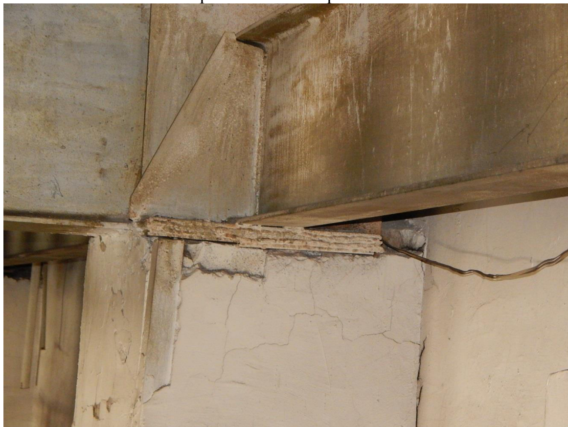
Рис. 3.1.51. Дефект в виде мелких трещин верхней части пильстры в месте опирания балки покрытия
