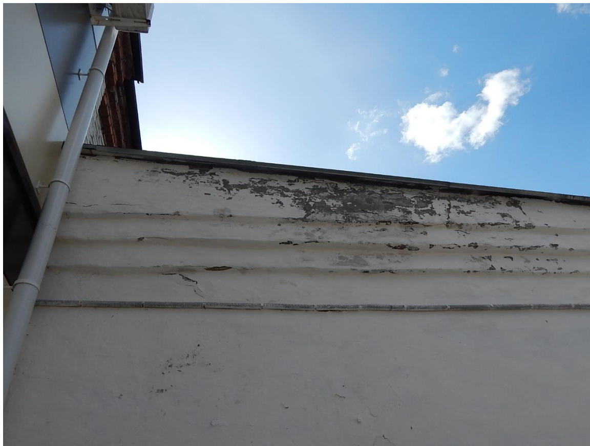
Рис. 3.1.34. Дефект в виде следов замачивания локального участка наружной стены по фасаду 2-1
