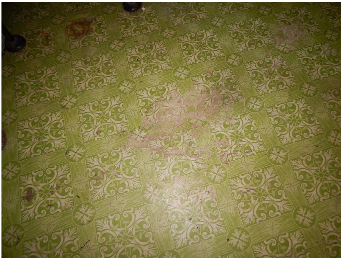
Рис. 3.5.11. Дефект в виде истертостей линолеумного покрытия пола в помещении раздевалки
