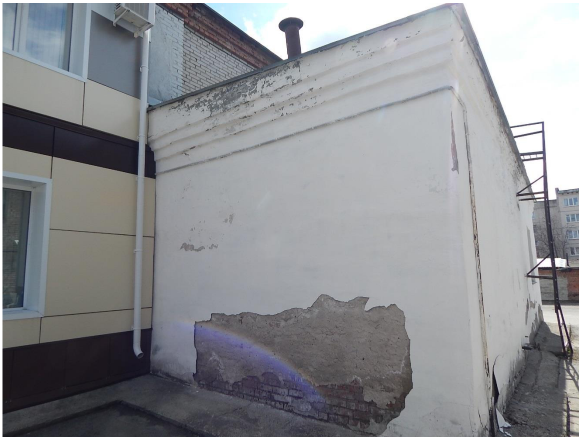
Рис. 3.3.17. Недостаточная величина вылета кровельного свеса, расположенного по стенам вдоль осей 1, Д/1-2, А/1-2
