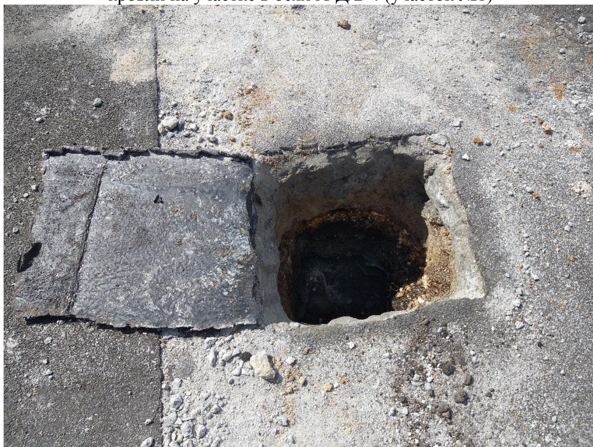
Рис. 3.3.6. Внешний вид вскрытия кровли на участке в осях А-Д/1-2 (участок №2)
