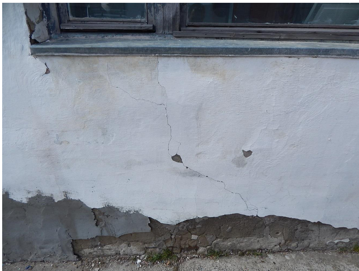
Рис. 3.1.15. Трещина №12 шириной раскрытия до 0,5 мм (вид с улицы)
