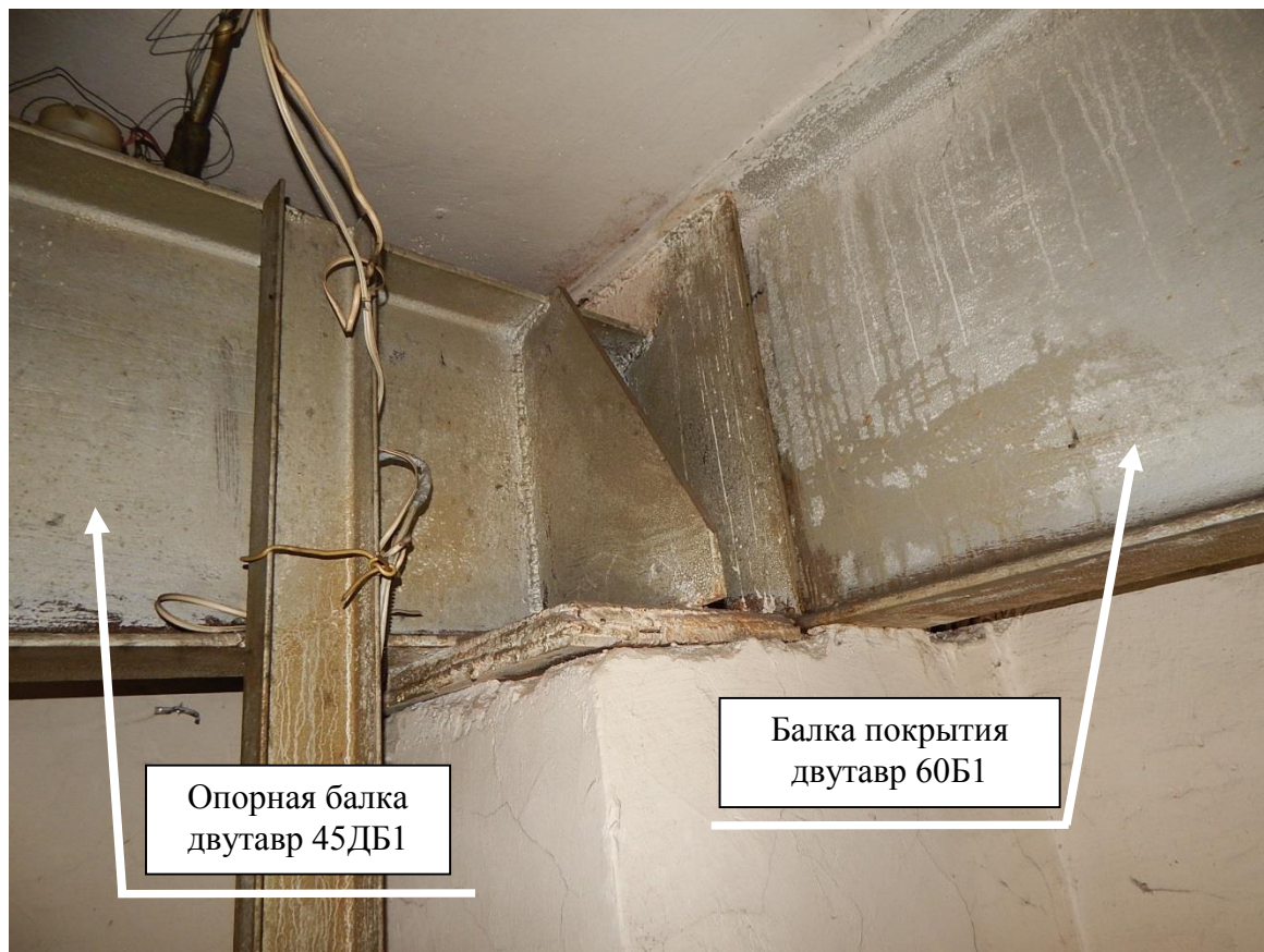
Рис. 3.8.6. Узел опирания опорной металлической балки на кирпичную пилястру
