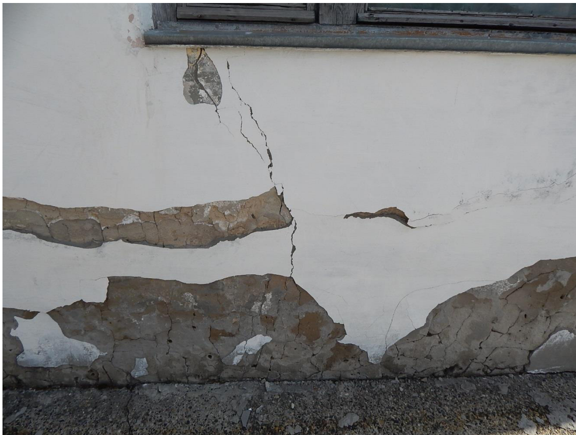
Рис. 3.1.10. Трещина №8 шириной раскрытия до 1 мм (вид с улицы)
