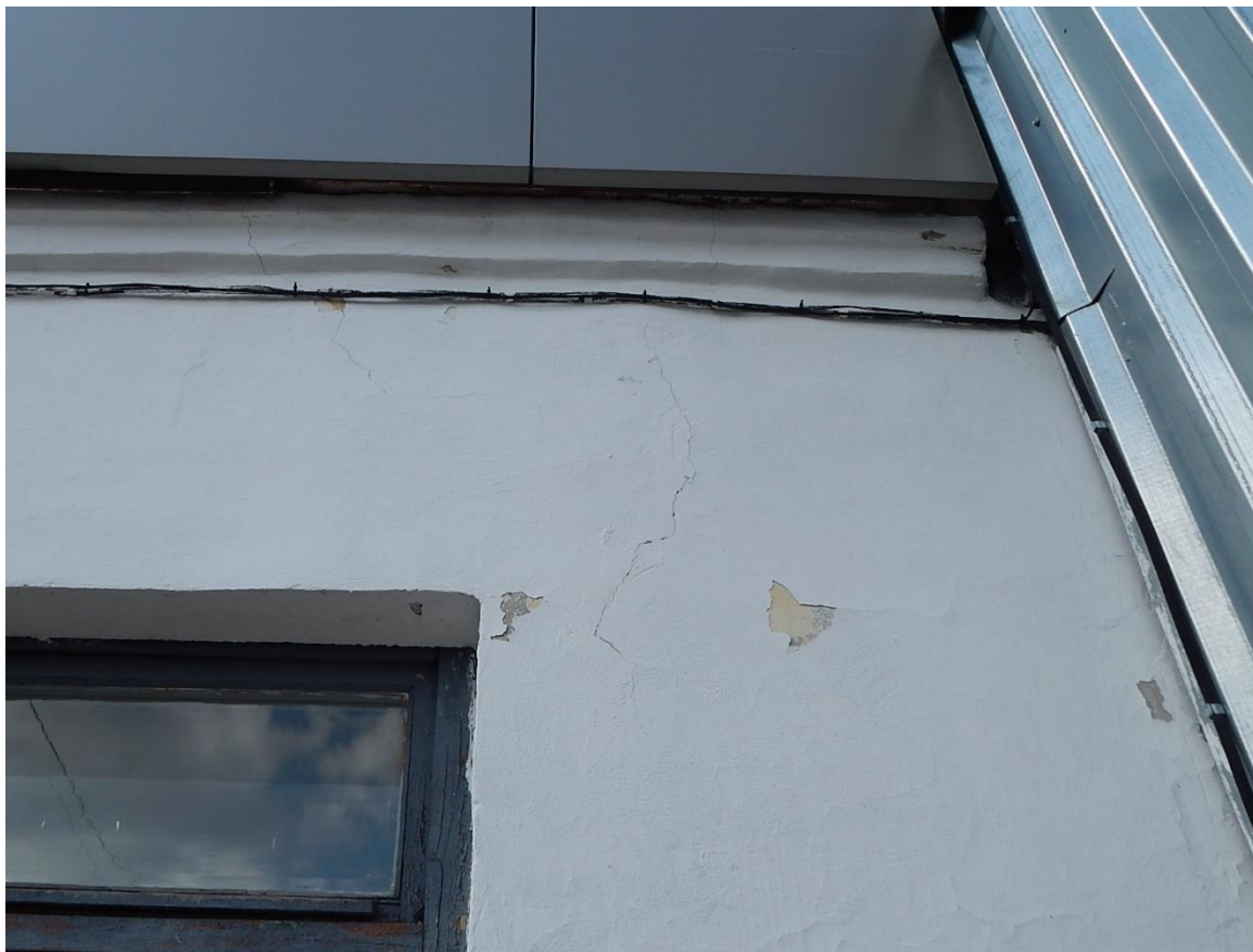
Рис. 3.1.20. Трещина №15 шириной раскрытия до 0,5 мм (вид с улицы)
