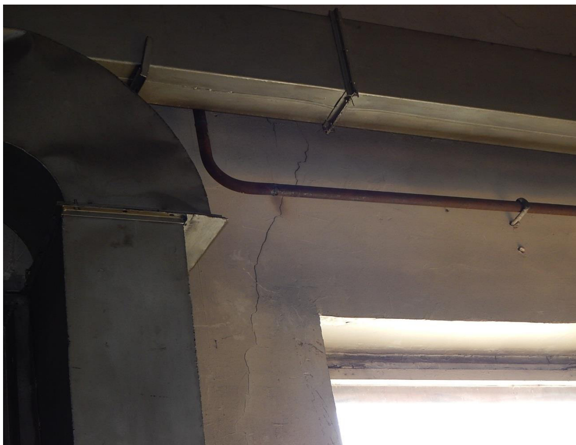
Рис. 3.1.7. Трещина №4 шириной раскрытия до 0,5 мм (вид изнутри)
