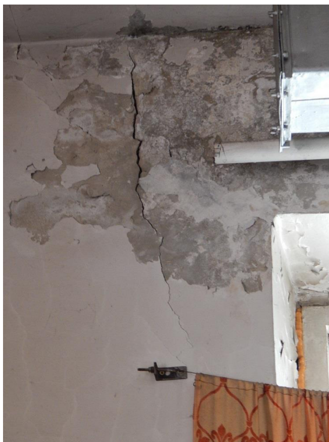
Рис. 3.1.11. Трещина №9 шириной раскрытия до 1 мм (вид изнутри)
