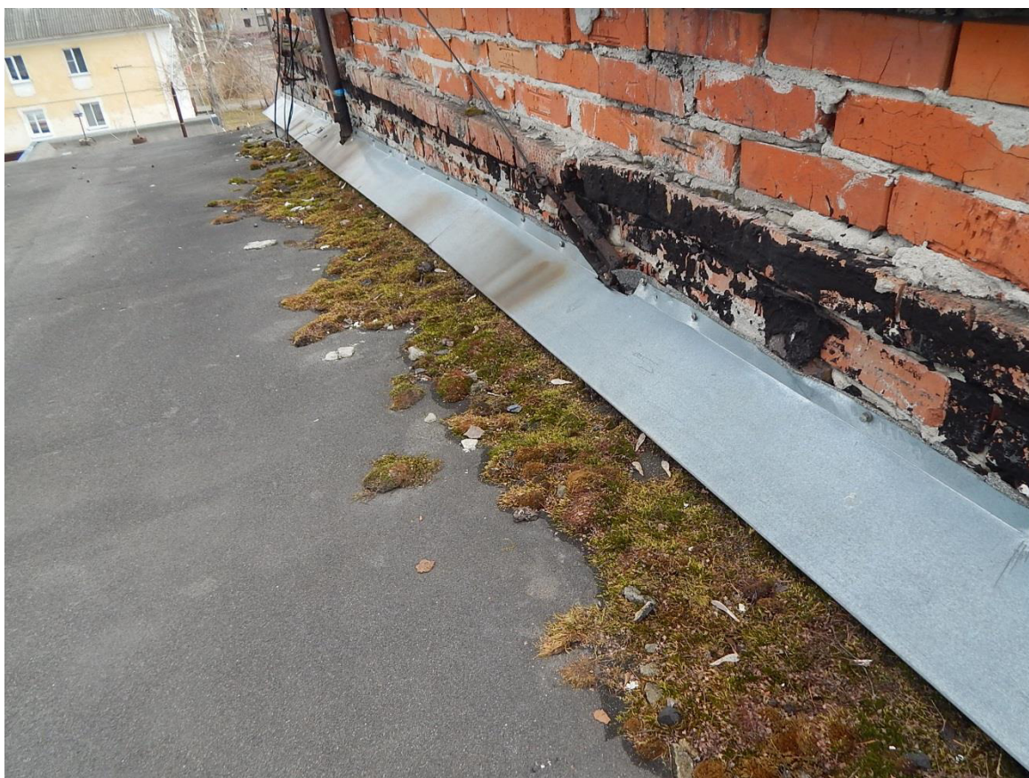
Рис. 3.3.10. Выявлено образование мха на участке примыкания гидроизоляционного кровельного ковра к кирпичному парапету по оси А
