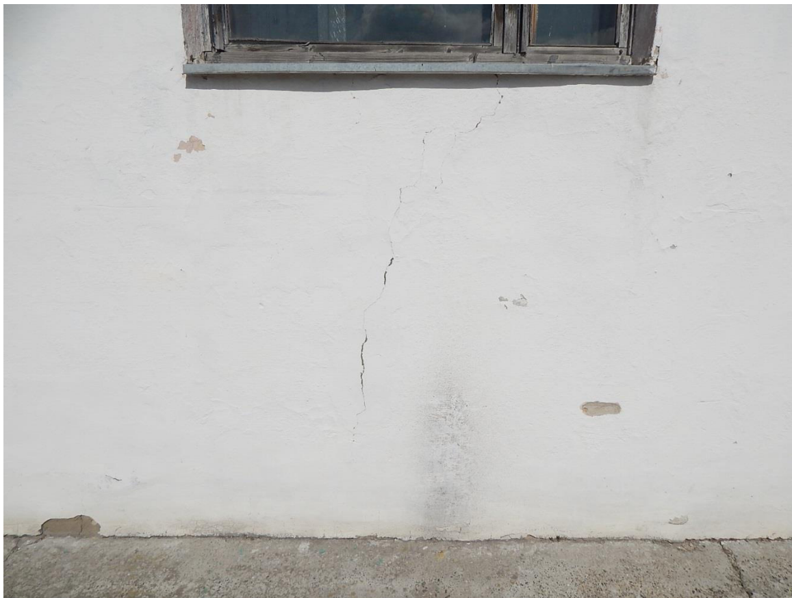
Рис. 3.1.4. Трещина №3 шириной раскрытия до 0,5 мм (вид с улицы)
