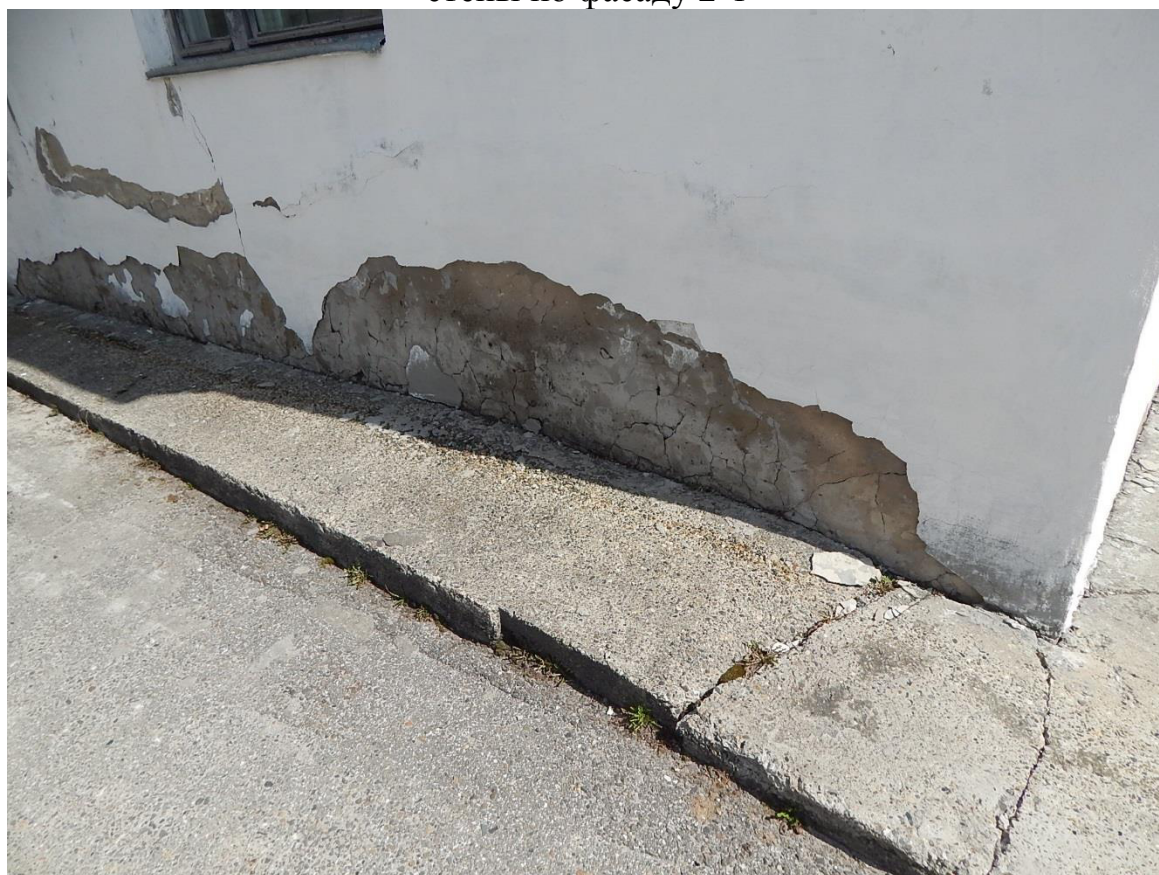
Рис. 3.1.35. Дефект в виде локального разрушения штукатурного слоя наружной отделки стен по фасаду Д-А
