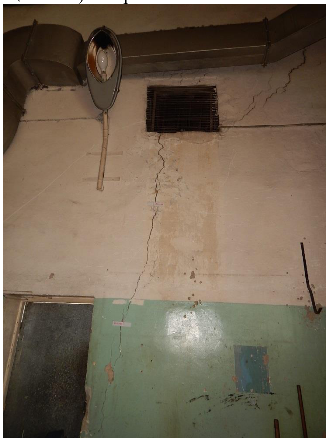
Рис. 3.1.27. Трещина №19 шириной раскрытия до 15 мм (вид из гаража)
