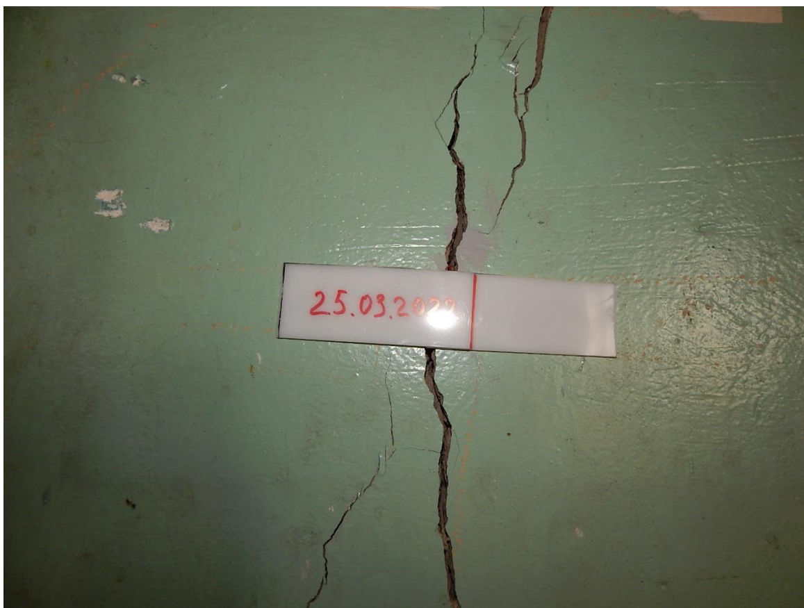
Рис. 3.1.29. Трещина №19 шириной раскрытия до 15 мм (вид из гаража). Устройство пластикового маячка
