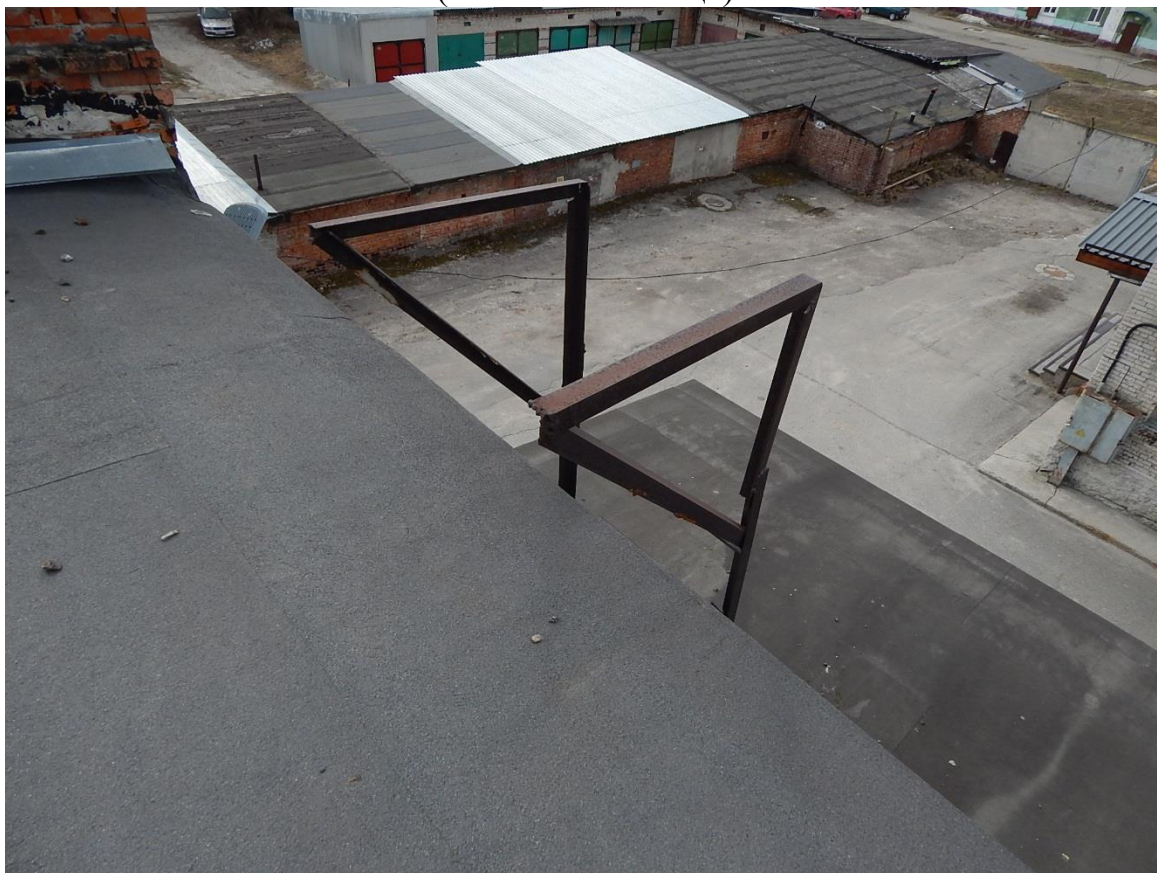
Рис. 3.4.6. Отсутствует жесткое закрепление верхней части лестницы к кровле (верхняя лестница)
