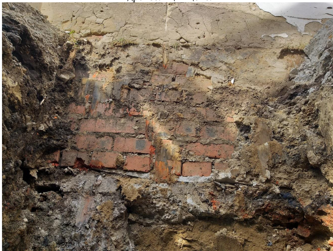
Рис. 3.1.49. По всему периметру здания кирпичная цокольная часть наружных стен расположена ниже отметки уровня планировки на 400-600 мм. Отсутствует гидроизоляция цоколя
