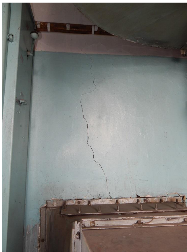
Рис. 3.1.23. Трещина №18 шириной раскрытия до 1,5 мм (вид из помещения вентиляционной)
