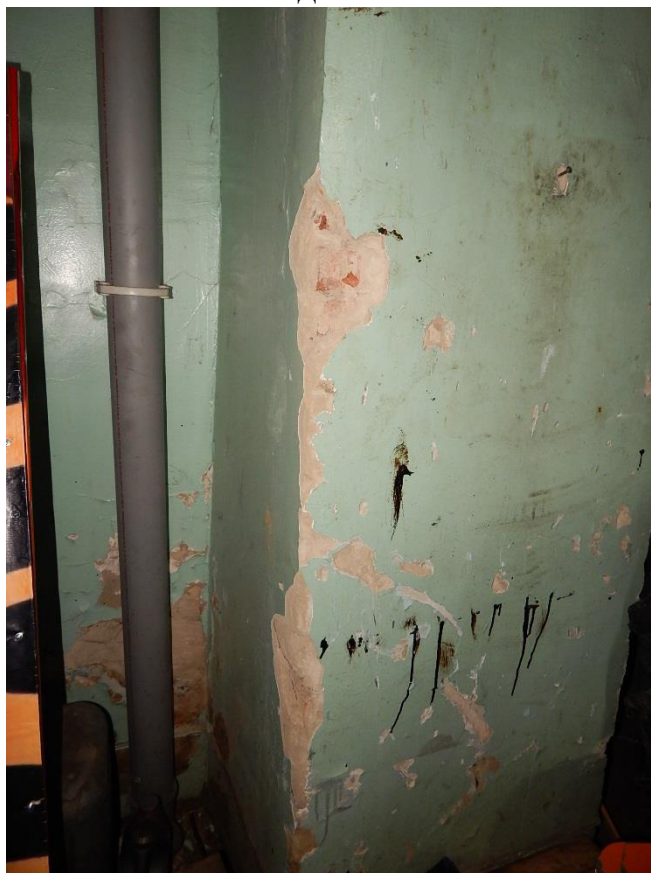
Рис. 3.1.45. Дефект в виде локального разрушения штукатурного слоя внутренней отделки кирпичного столба
