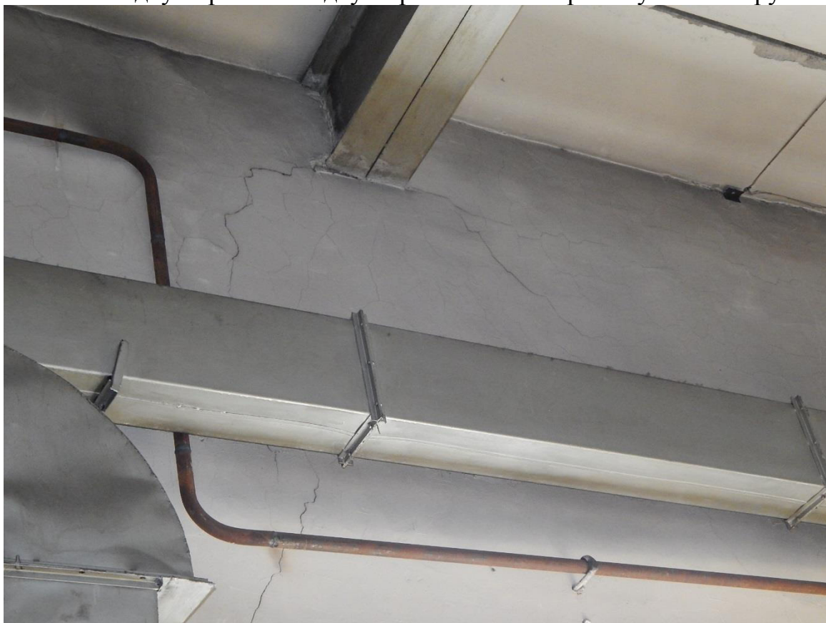
Рис. 3.2.12. Внешний вид узла опирания стальной спаренной балки, выполненной из двух прокатных двутавров 60Б1 на кирпичную стену
