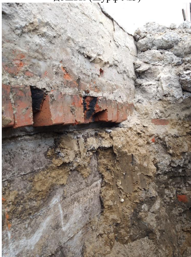
Рис. 3.7.16. Кирпичный цоколь расположен ниже отметки земли на 450 мм (шурф №3)
