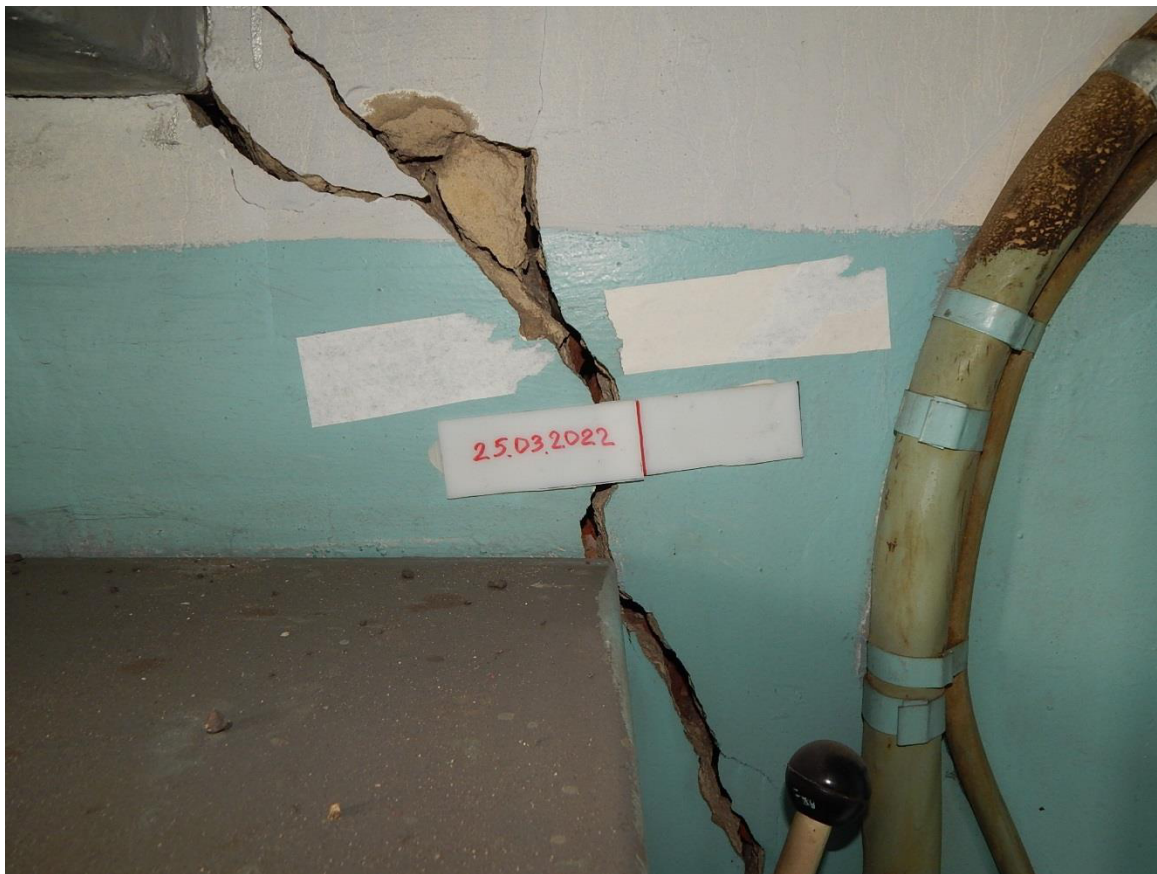
Рис. 3.1.26. Трещина №19 шириной раскрытия до 15 мм (вид из помещения вентиляционной). Устройство пластикового маячка
