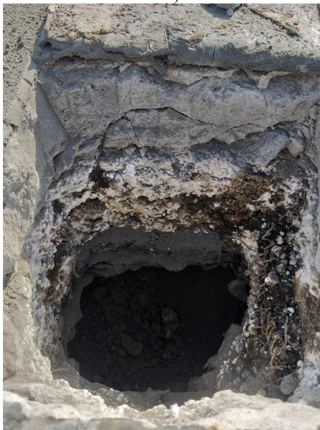
Рис. 3.3.4. Внешний вид состава кровли на участке в осях А-Д/2-4 (участок №1)
