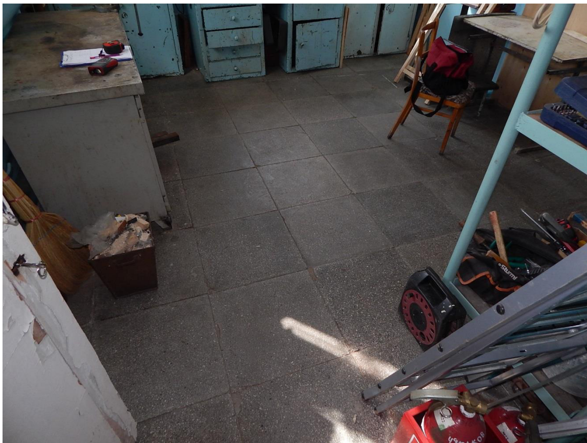
Рис. 3.5.4. Внешний вид пола с покрытием из бетонных плит с добавлением мраморной крошки в помещении мастерской
