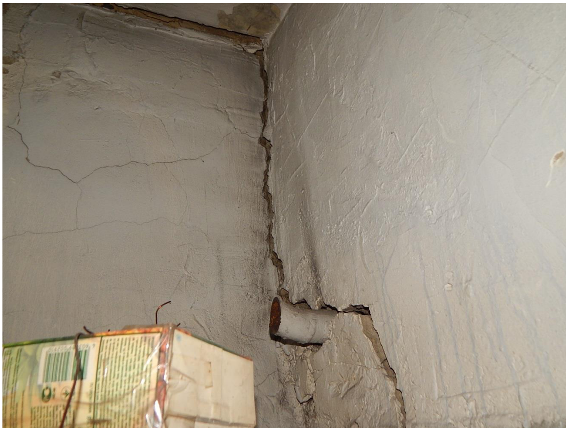
Рис. 3.1.24. Трещина №19 шириной раскрытия до 15 мм (вид из помещения вентиляционной)
