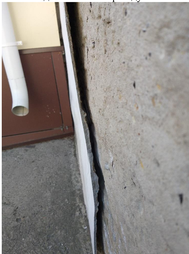
Рис. 3.1.33. Дефект в виде отслоения штукатурного слоя от поверхности наружной стены по фасаду 2-1
