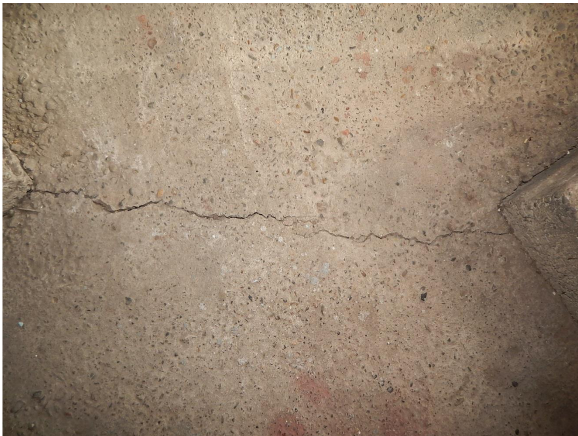
Рис. 3.5.17. Дефект в виде трещин в бетонному полу в помещении вентиляционной
