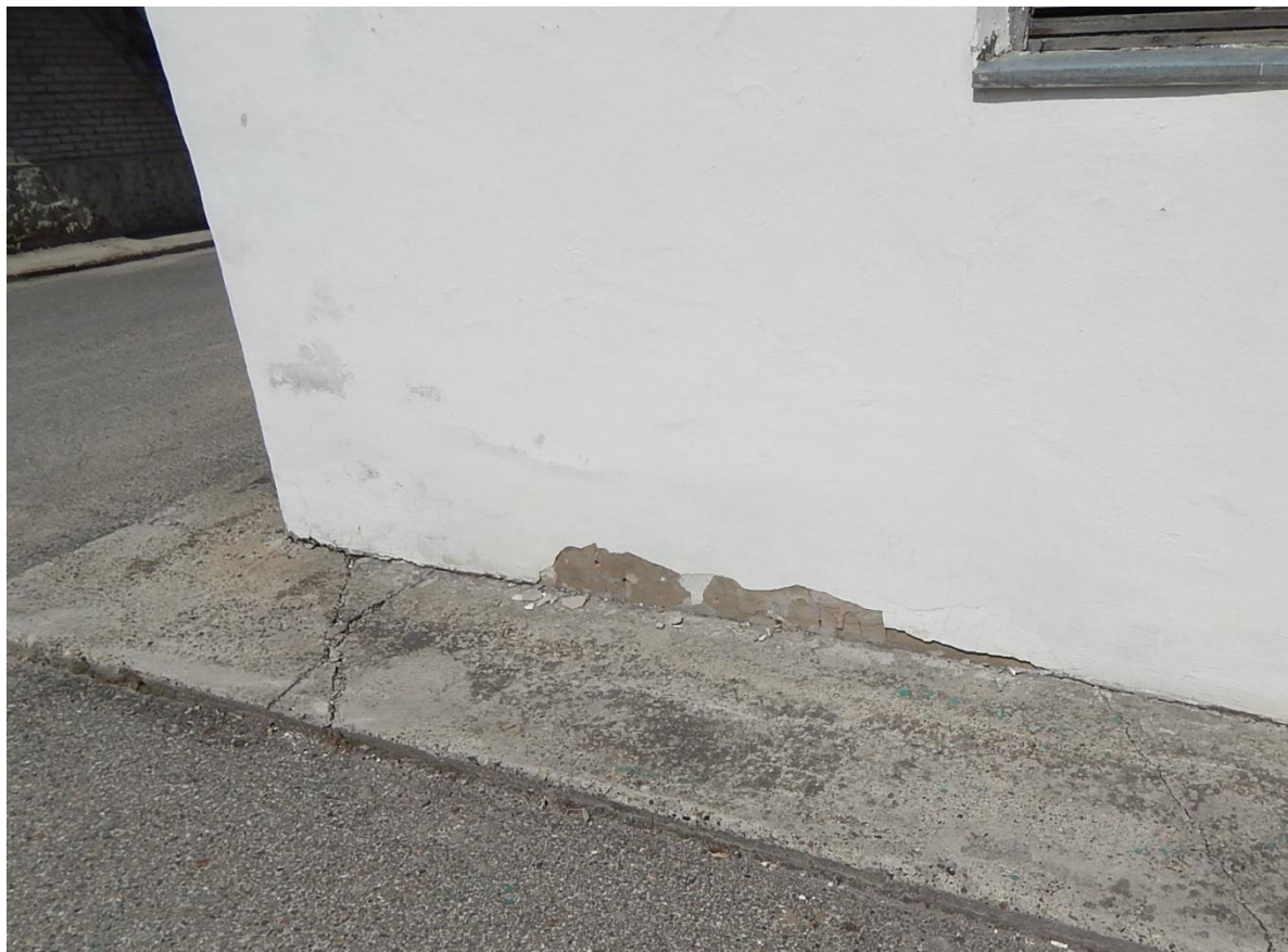
Рис. 3.1.38. Дефект в виде локального разрушения штукатурного слоя наружной отделки стен по фасаду 1-4
