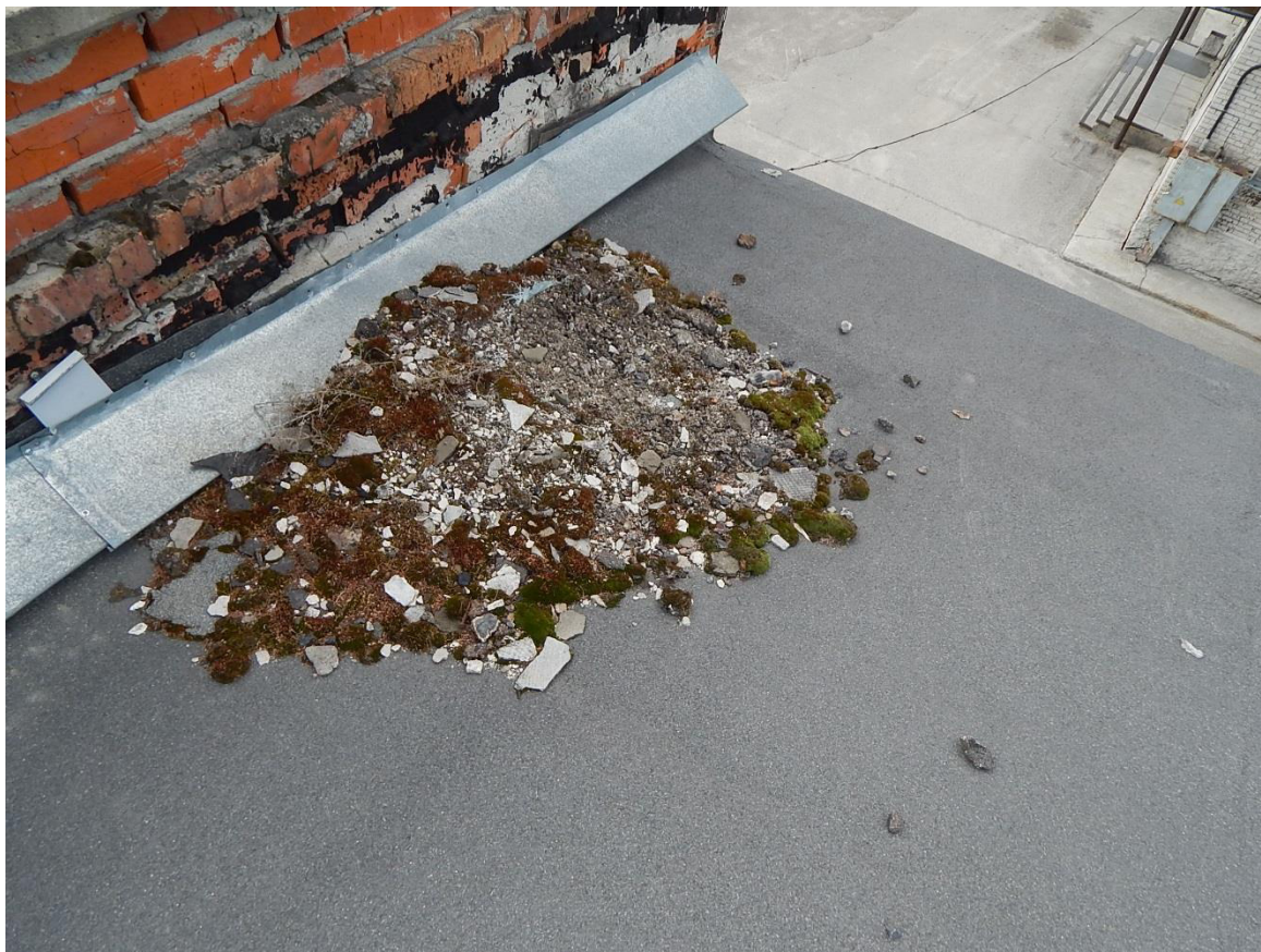
Рис. 3.3.15. Наличие строительного мусора на поверхности кровли
