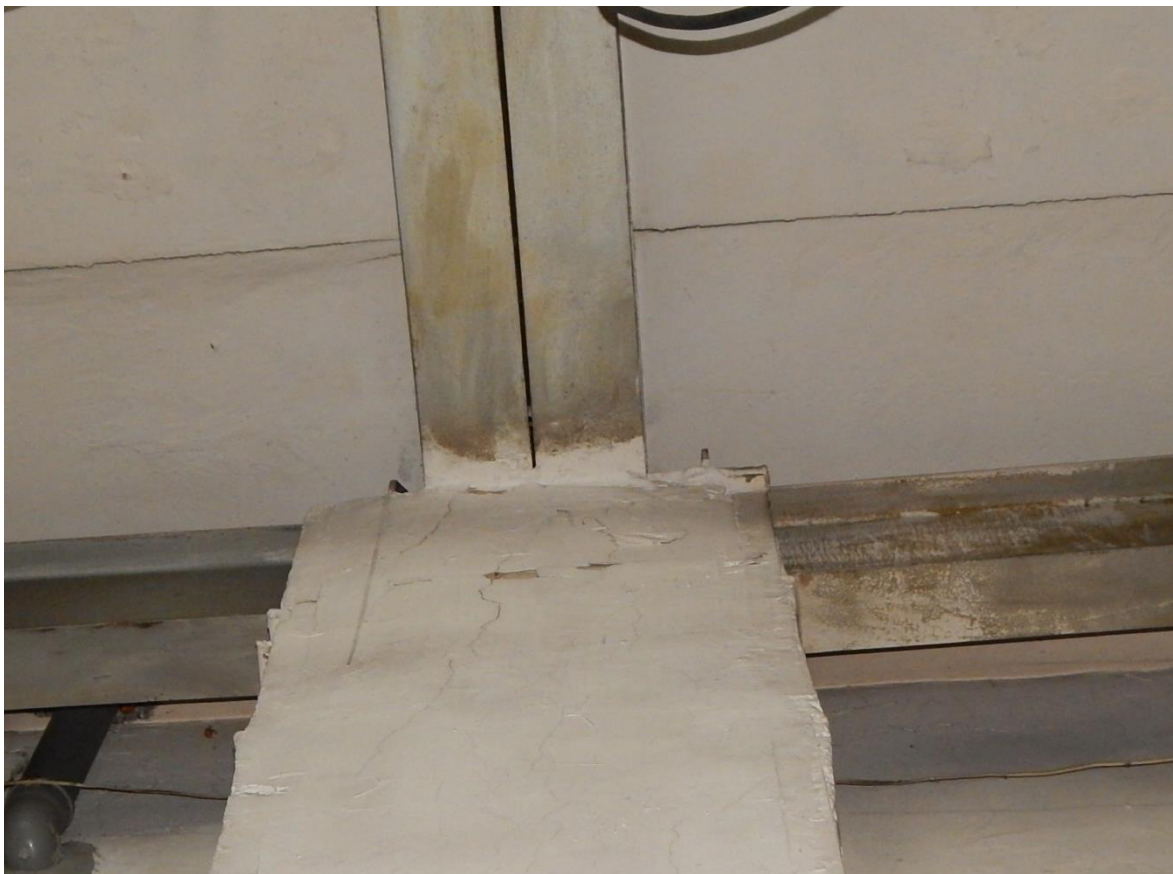
Рис. 3.1.50. Дефект в виде мелких трещин верхней части пильстры в месте опирания балки покрытия
