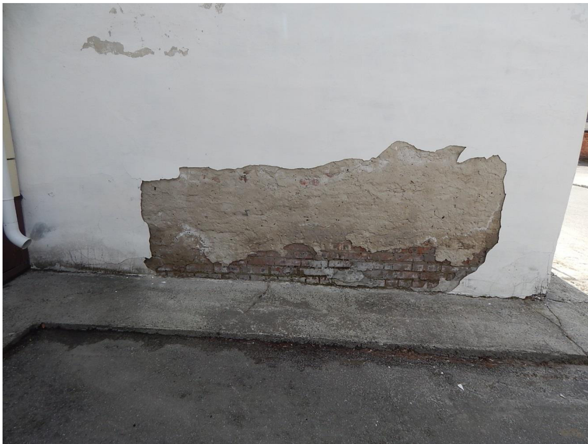
Рис. 3.1.32. Дефект в виде локального разрушения штукатурного слоя наружной отделки стен по фасаду 2-1
