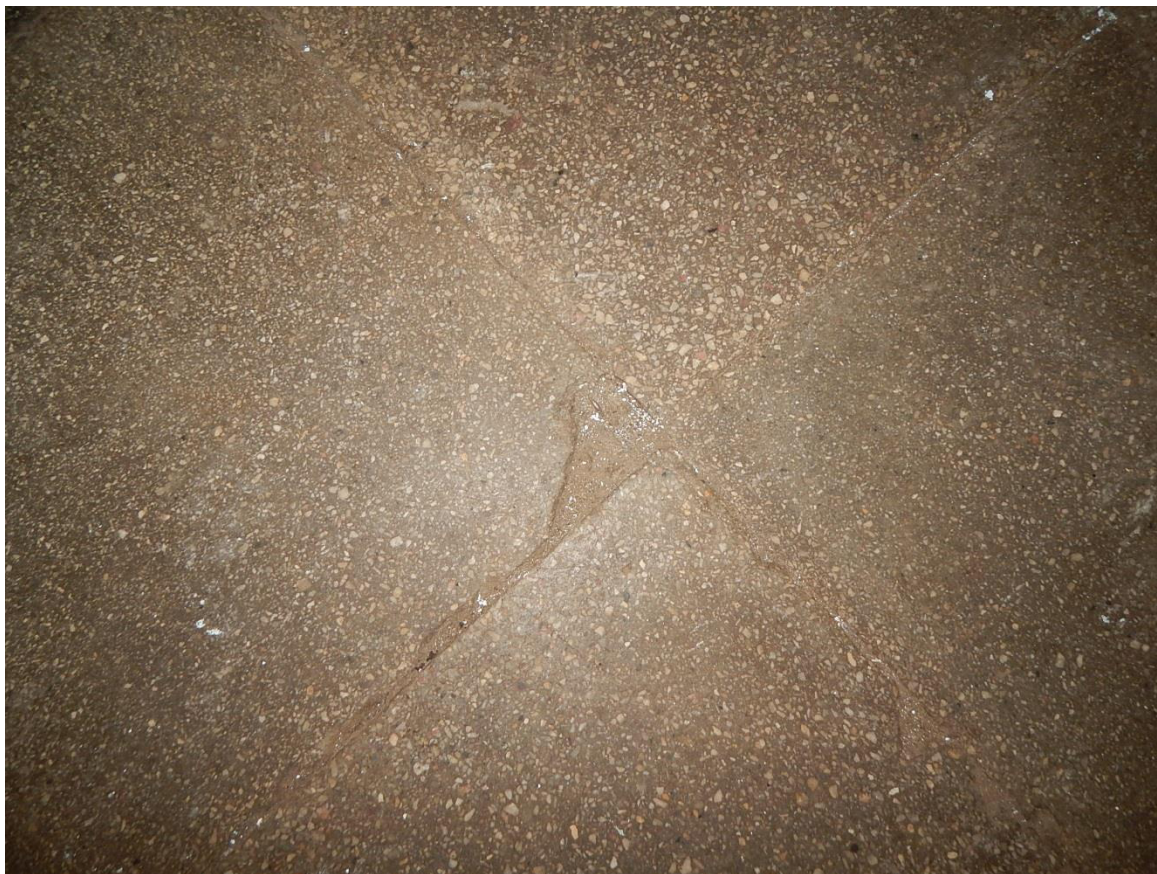
Рис. 3.5.15. Дефект в виде мелких сколов бетонных плит с добавлением мраморной крошки в помещении регенерационной
