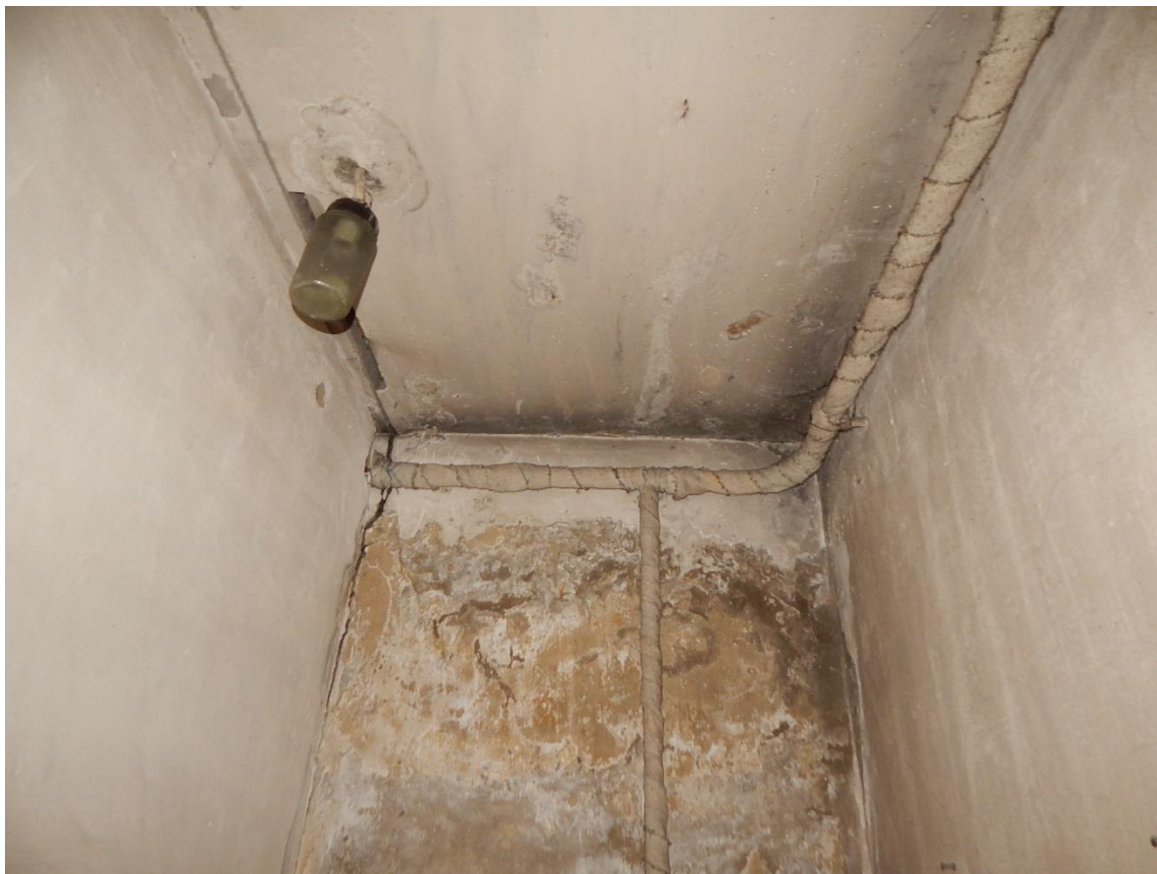
Рис. 3.1.42. Дефект в виде локального разрушения штукатурного слоя внутренней отделки стен
