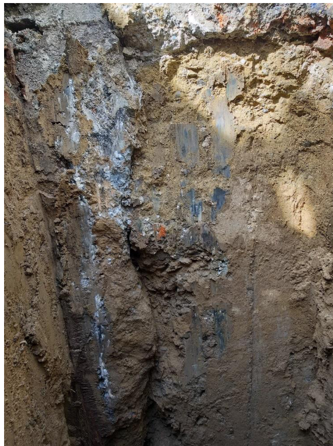
Рис. 3.7.7. Внешний вид шва стыка старого и нового (пристроенного) фундаментов. Шурф №1
