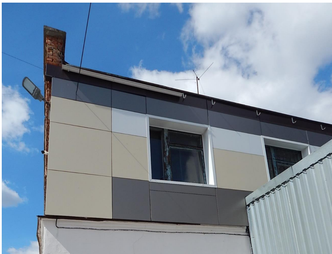
Рис. 3.3.16. Недостаточная величина вылета кровельного свеса, расположенного по стене вдоль оси 4
