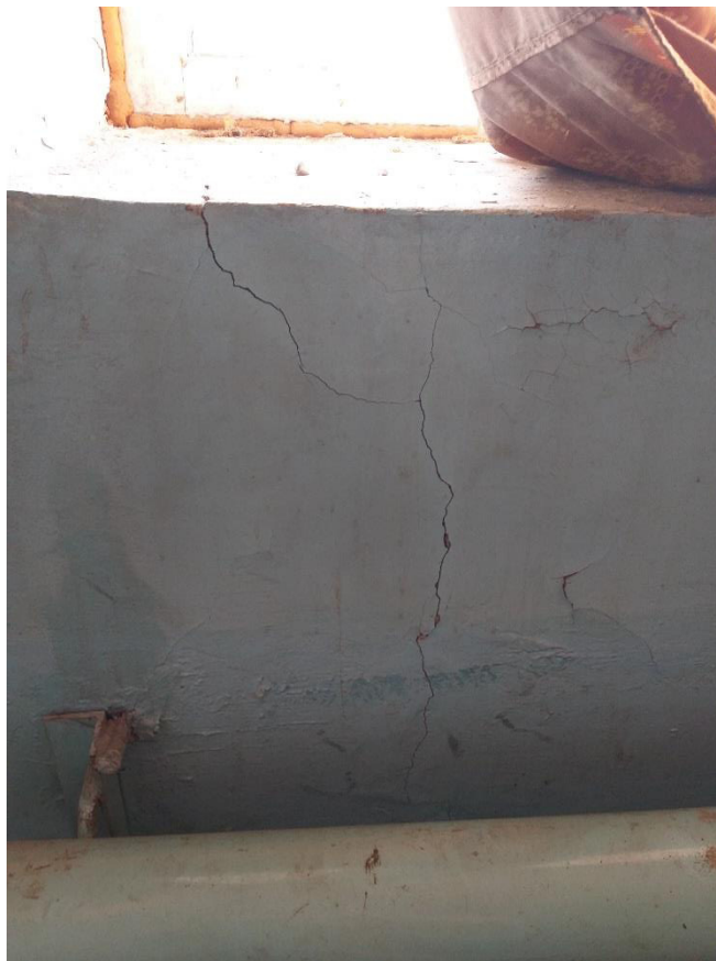
Рис. 3.1.2. Трещина №1 шириной раскрытия до 0,5 мм (вид изнутри)
