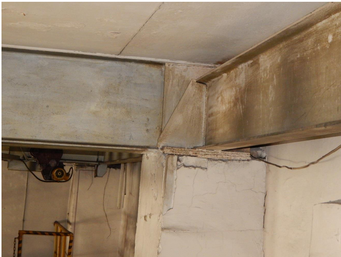
Рис. 3.2.11. Внешний вид узла опирания стальной спаренной балки, выполненной из двух прокатных двутавров 60Б1 на кирпичную пилястру
