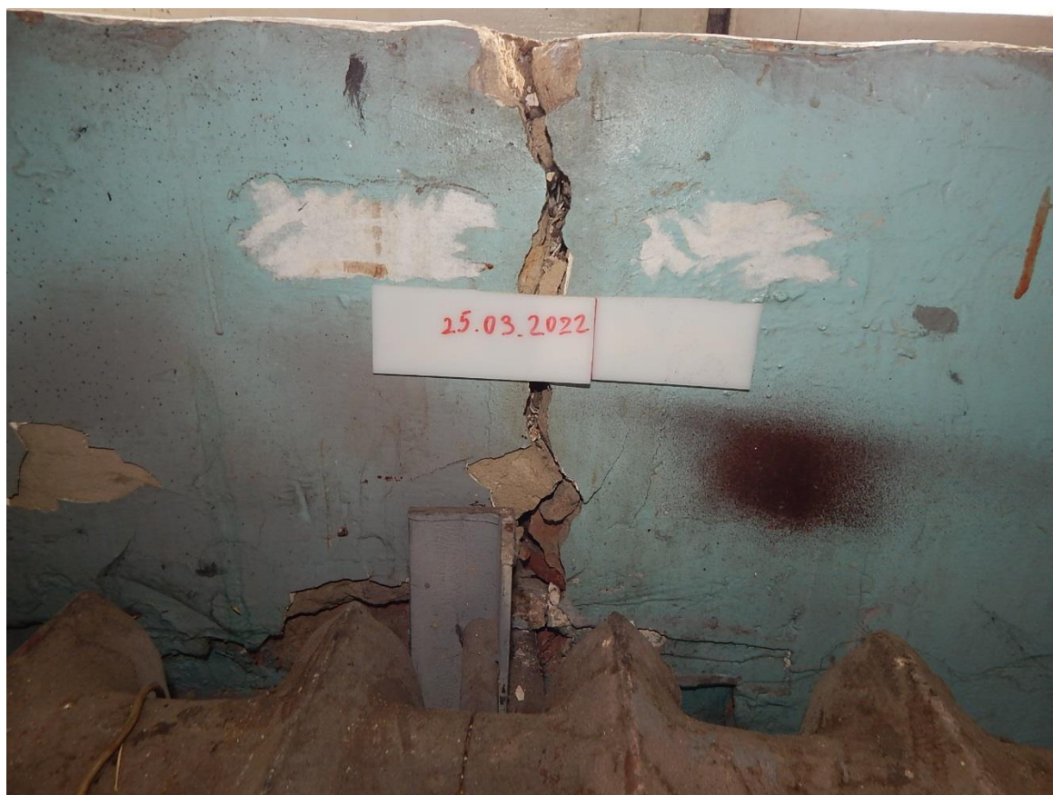
Рис. 3.1.19. Трещина №14 шириной раскрытия до 12 мм (вид изнутри). Устройство пластикового маячка
