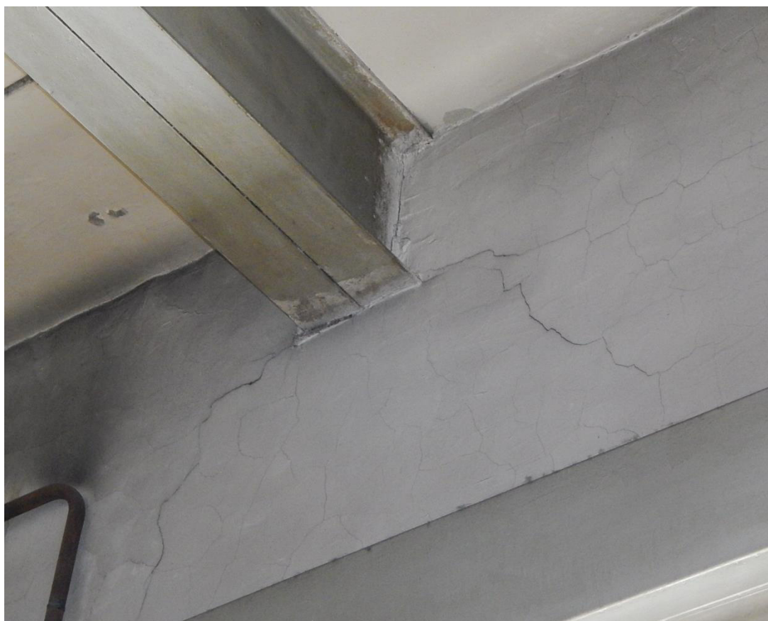
Рис. 3.1.9. Трещины №6, 7 шириной раскрытия до 0,5 мм (вид изнутри)
