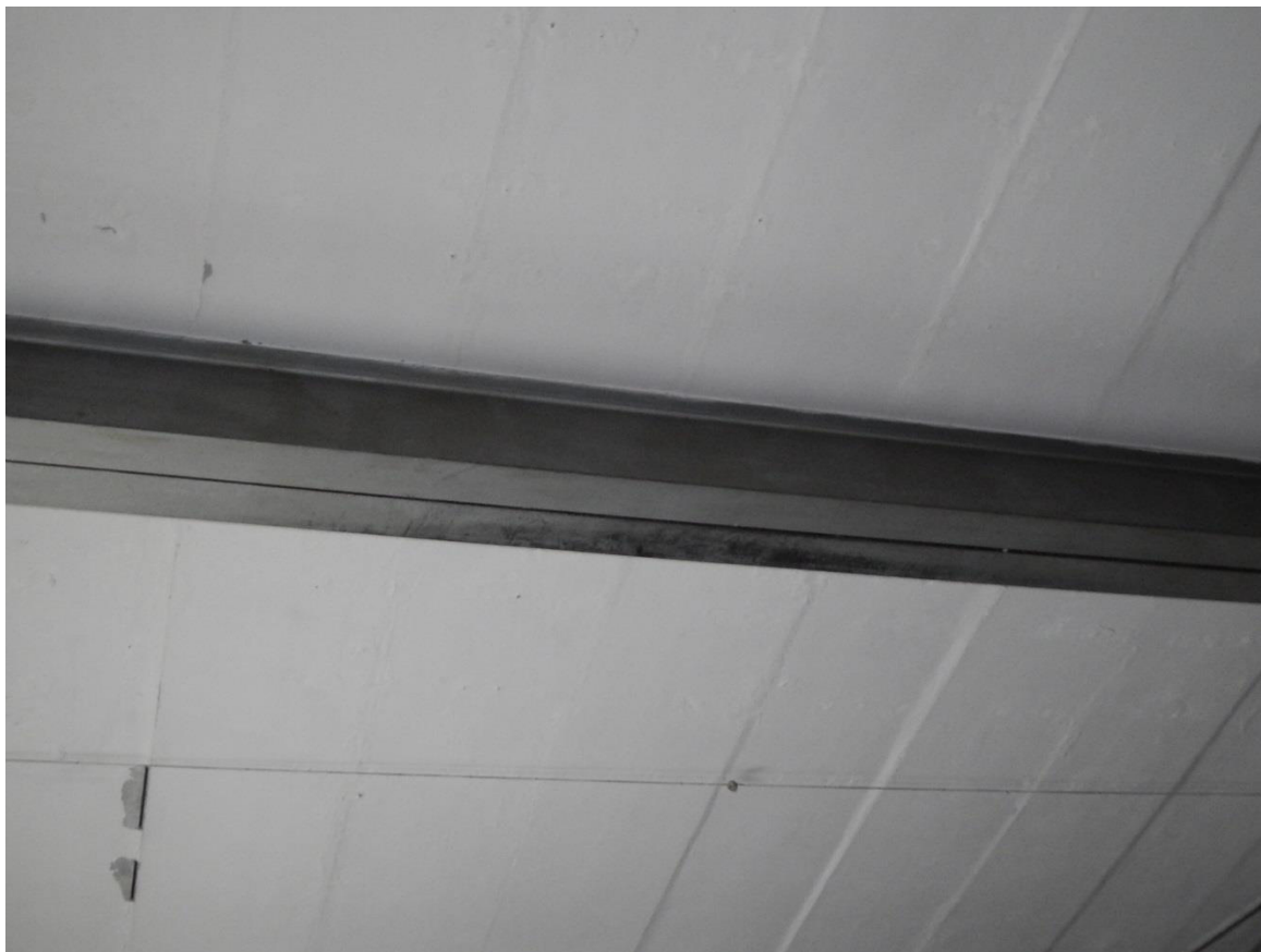
Рис. 3.2.9. Внешний вид стальной спаренной балки, выполненной из двух прокатных двутавров 60Б1
