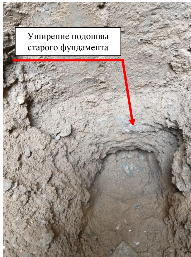
Рис. 3.7.9. Подошва старого фундамента выполнена с уширением 80 мм с каждой стороны. Шурф №1
