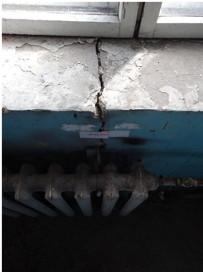
Рис. 3.1.18. Трещина №14 шириной раскрытия до 12 мм (вид изнутри)
