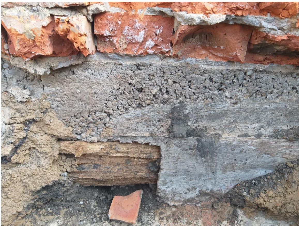
Рис. 3.7.12. Внешний вид участка железобетонного фундамента (шурф №2)
