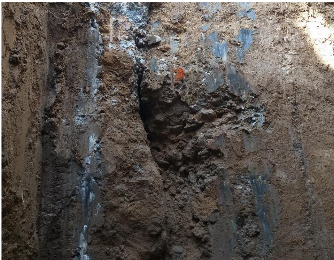
Рис. 3.7.17. Внешний вид скола бетона глубиной до 100 мм на участке стыка старого и нового фундаментов (шурф №1)
