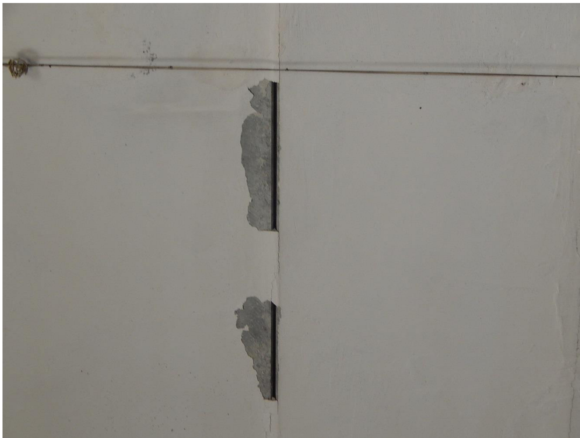
Рис. 3.2.17. Дефект в виде выпадения раствора из межплитных швов в помещении гаража
