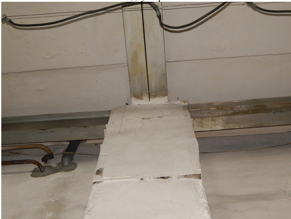
Рис. 3.2.10. Внешний вид узла опирания стальной спаренной балки, выполненной из двух прокатных двутавров 60Б1 на кирпичную пилястру
