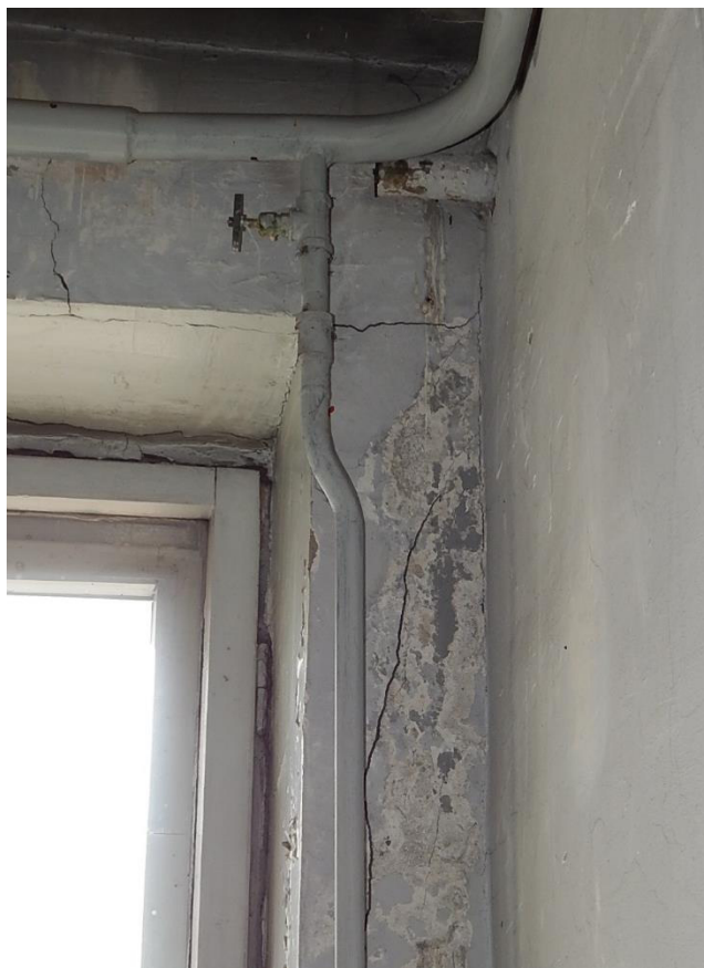
Рис. 3.1.21. Трещина №16 шириной раскрытия до 1,5 мм (вид изнутри)
