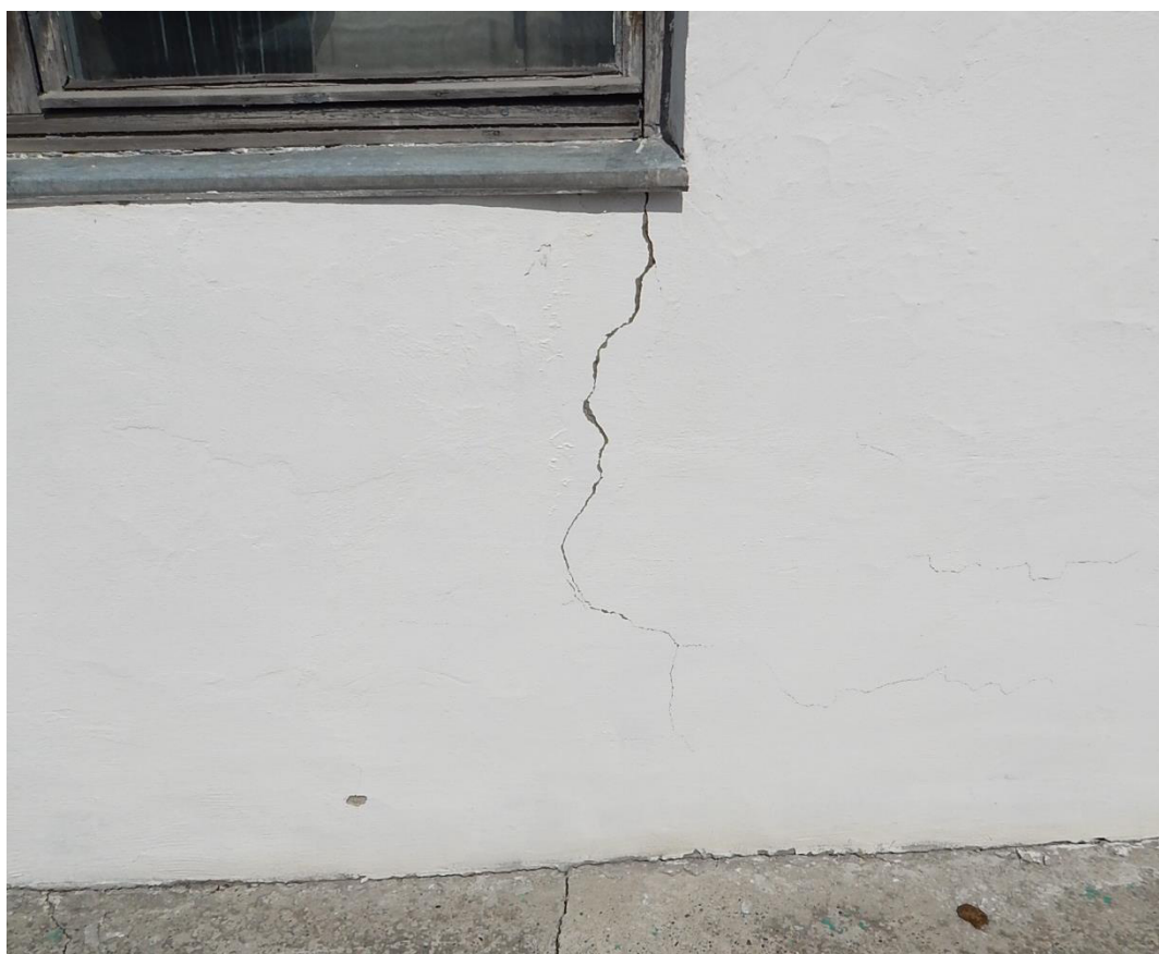
Рис. 3.1.1. Трещина №1 шириной раскрытия до 0,5 мм (вид с улицы)
