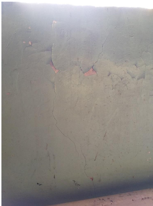
Рис. 3.1.5. Трещина №3 шириной раскрытия до 0,5 мм (вид изнутри)
