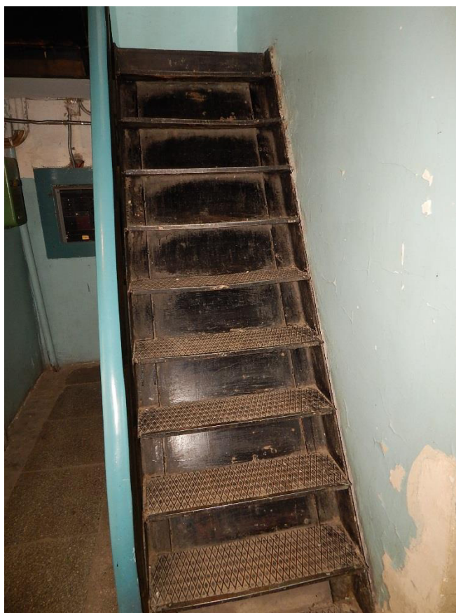
Рис. 3.4.2. Внешний вид нижнего лестничного марша лестницы в осях 3-4/Б-Г. Угол наклона марша составляет более 45 градусов (52 градуса)
