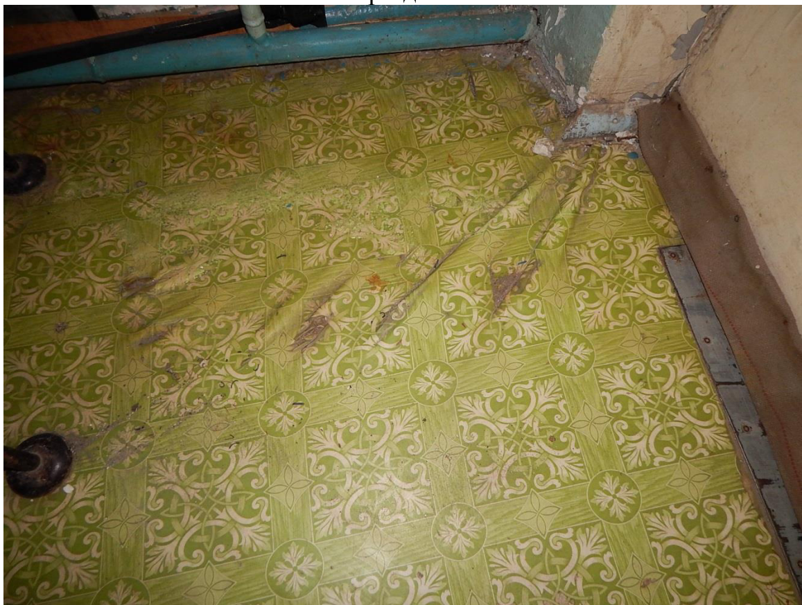
Рис. 3.5.12. Дефект в виде истертостей и вздутий линолеумного покрытия пола в помещении раздевалки
