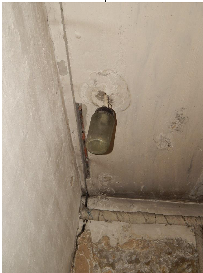
Рис. 3.2.22. Дефект в виде выпадения раствора из межплитных швов в вентка- мере
