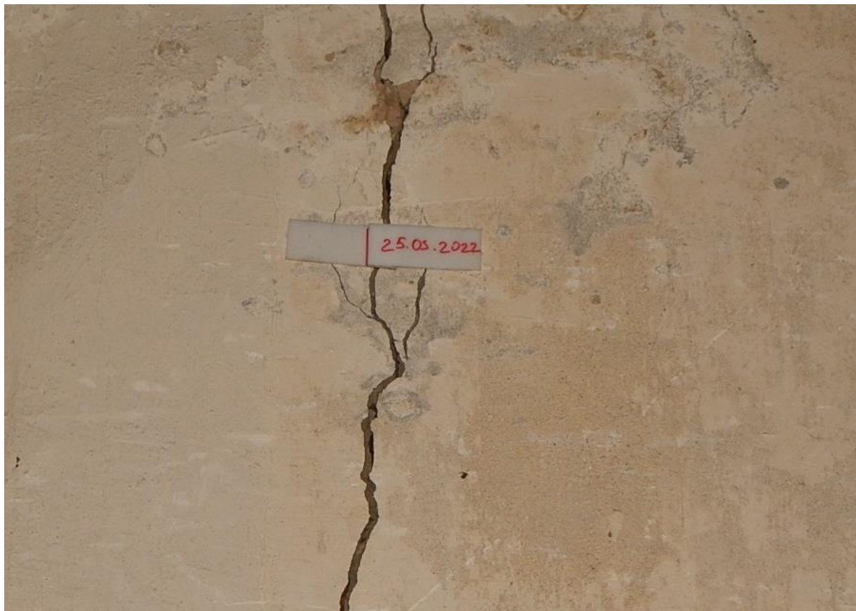
Рис. 3.1.30. Трещина №19 шириной раскрытия до 15 мм (вид из гаража). Устройство пластикового маячка
