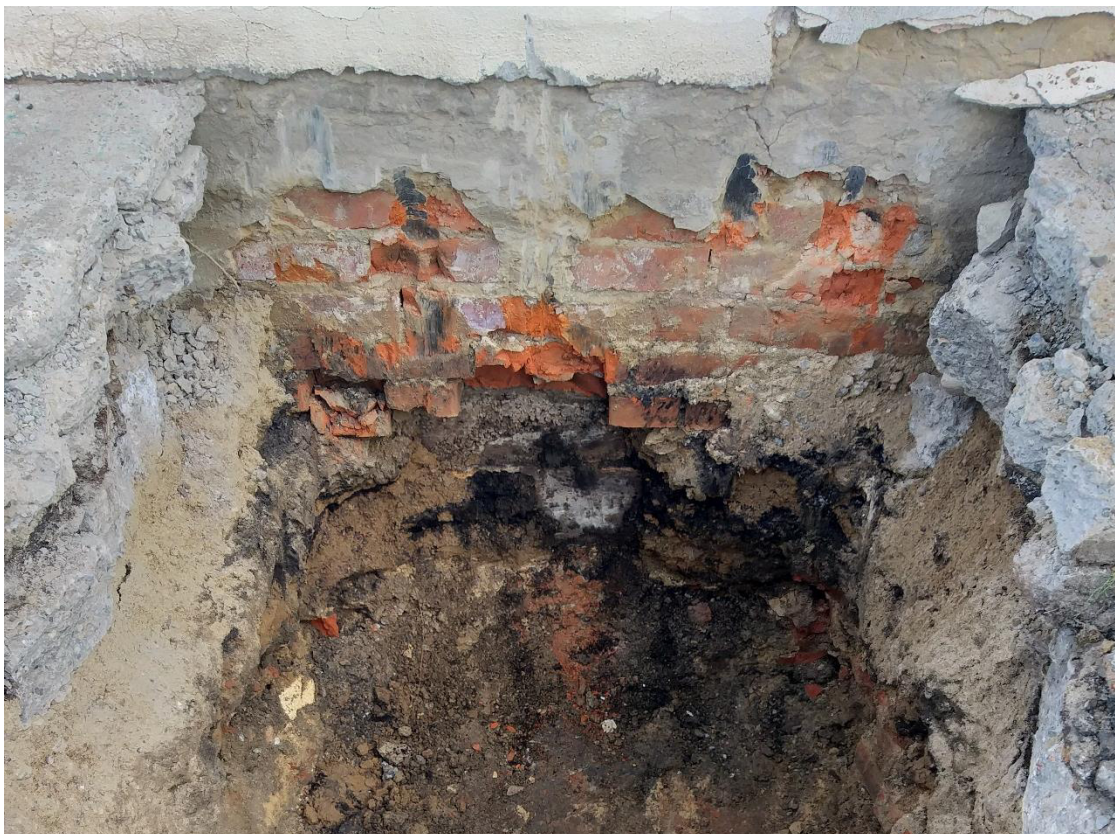
Рис. 3.1.48. По всему периметру здания кирпичная цокольная часть наружных стен расположена ниже отметки уровня планировки на 400-600 мм. Отсутствует гидроизоляция цоколя
