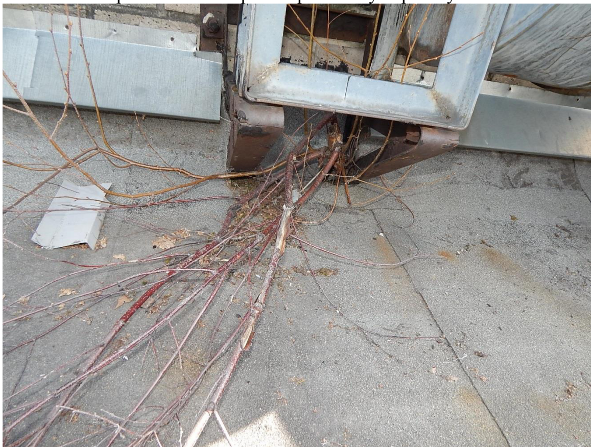
Рис. 3.3.12. Выявлено наличие растительности (куст) на поверхности нижнего участка кровли, расположенного в осях А-Д/1-2
