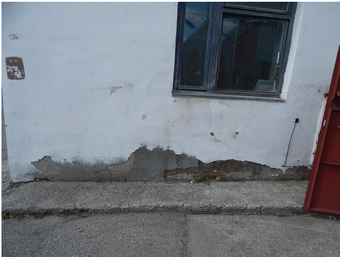
Рис. 3.1.40. Дефект в виде локального разрушения штукатурного слоя наружной отделки стен по фасаду А-Д
