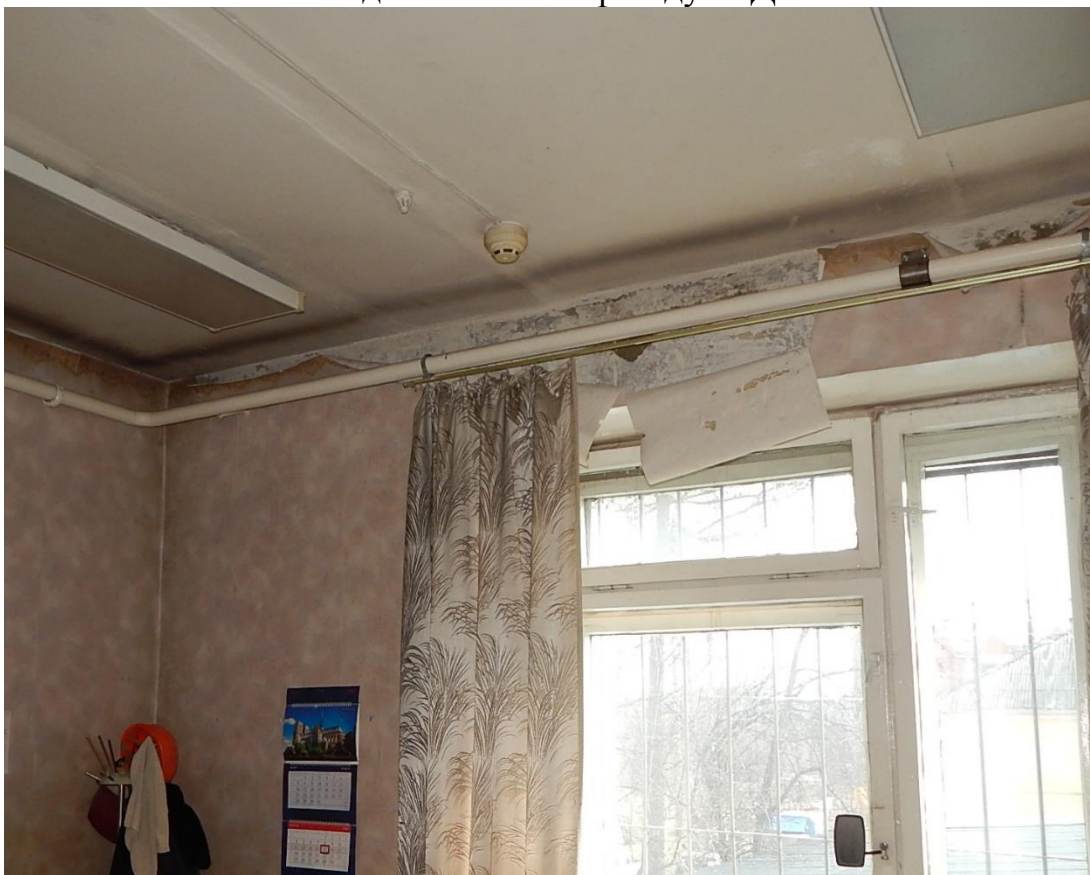
Рис. 3.1.41. Дефект в виде отслаивания обоев от поверхности стены
