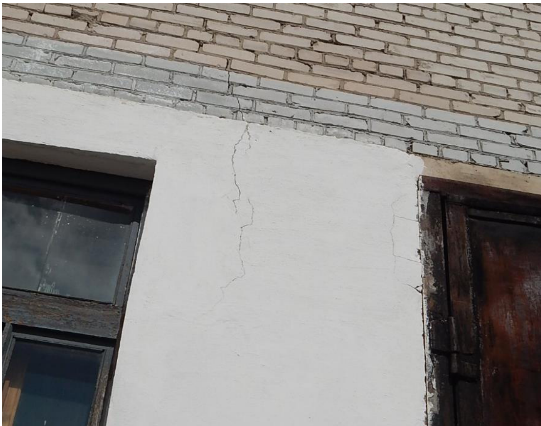
Рис. 3.1.6. Трещина №4 шириной раскрытия до 0,5 мм (вид с улицы)
