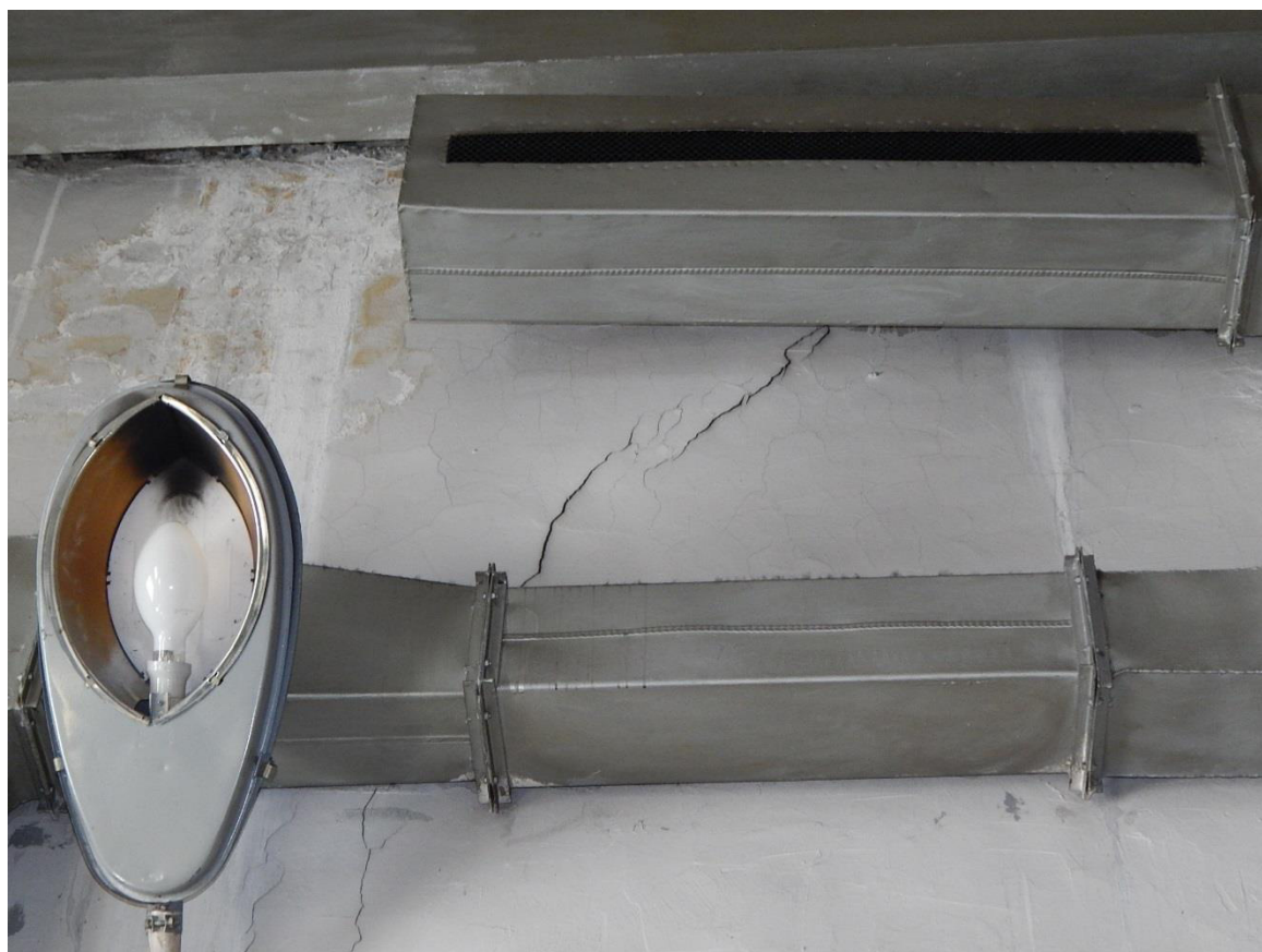
Рис. 3.1.13. Трещина №10 шириной раскрытия до 5 мм (вид изнутри)
