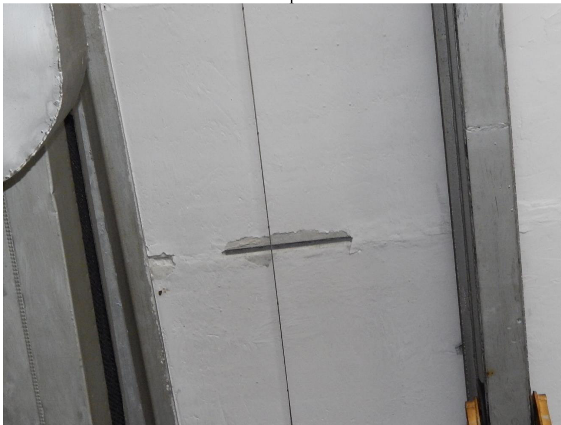
Рис. 3.2.18. Дефект в виде выпадения раствора из межплитных швов в помещении гаража
