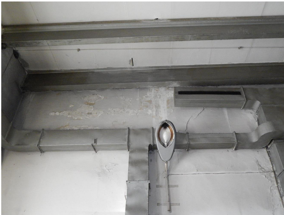
Рис. 3.2.13. Внешний вид стальной спаренной балки, выполненной из одинарного прокатного двутавра 60Б1
