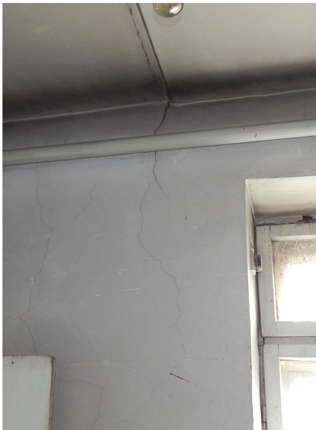
Рис. 3.1.22. Трещина №17 шириной раскрытия до 0,5 мм (вид изнутри)
