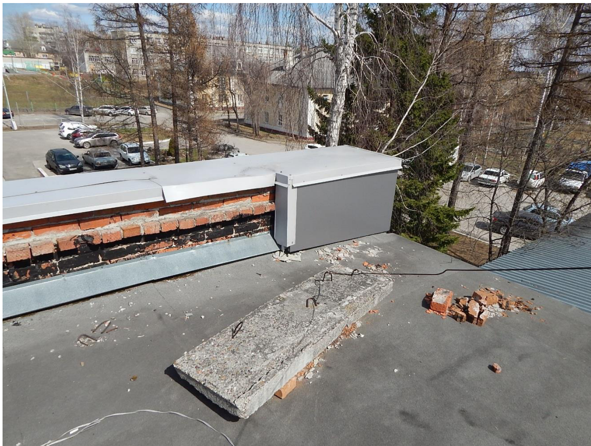
Рис. 3.3.13. Закрепление одной из оттяжек металлической стойки, выполняющей роль опоры кабеля инженерных коммуникаций, выполнено к демонтированной железобетонной парапетной плите, лежащей на поверхности кровли
