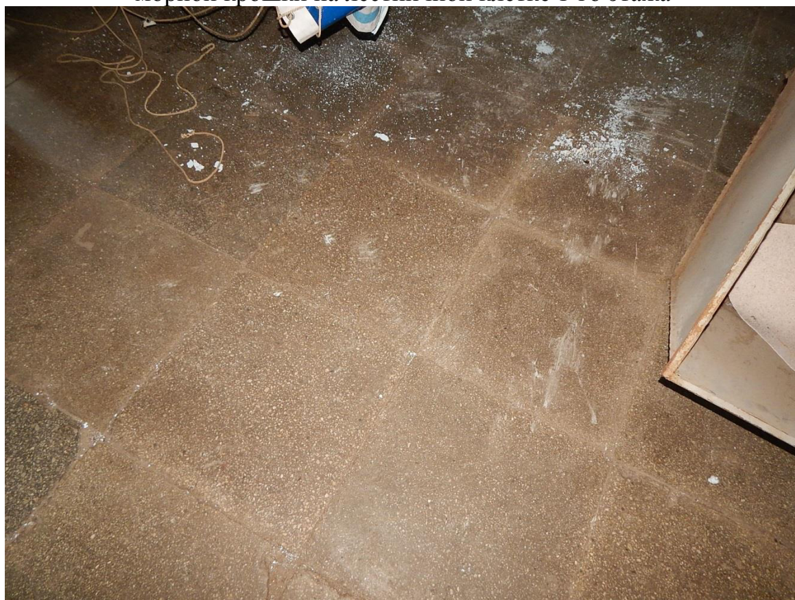
Рис. 3.5.6. Внешний вид пола с покрытием из бетонных плит с добавлением мраморной крошки в комнате отдыха
