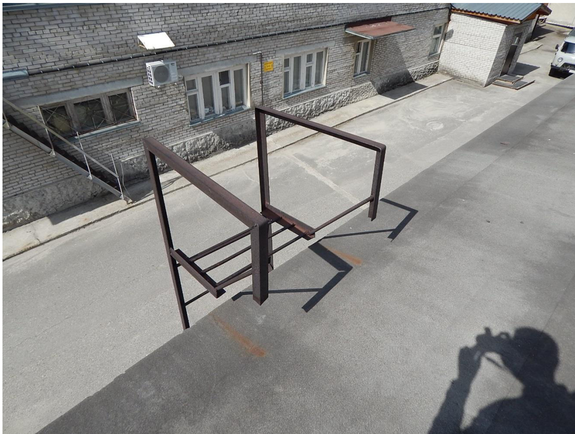
Рис. 3.4.5. Отсутствует жесткое закрепление верхней части лестницы к кровле (нижняя лестница)
