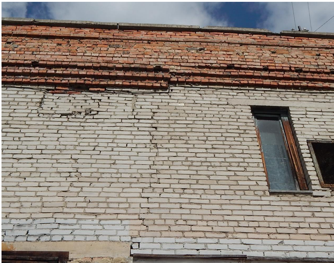
Рис. 3.1.8. Трещина №5 шириной раскрытия до 3 мм (вид с улицы)
