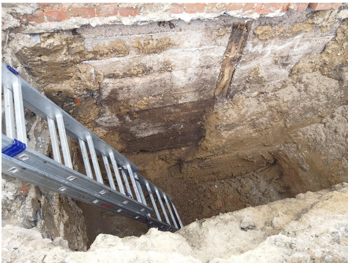
Рис. 3.7.14. Внешний вид монолитного железобетонного ленточного фундамента (шурф №3)
