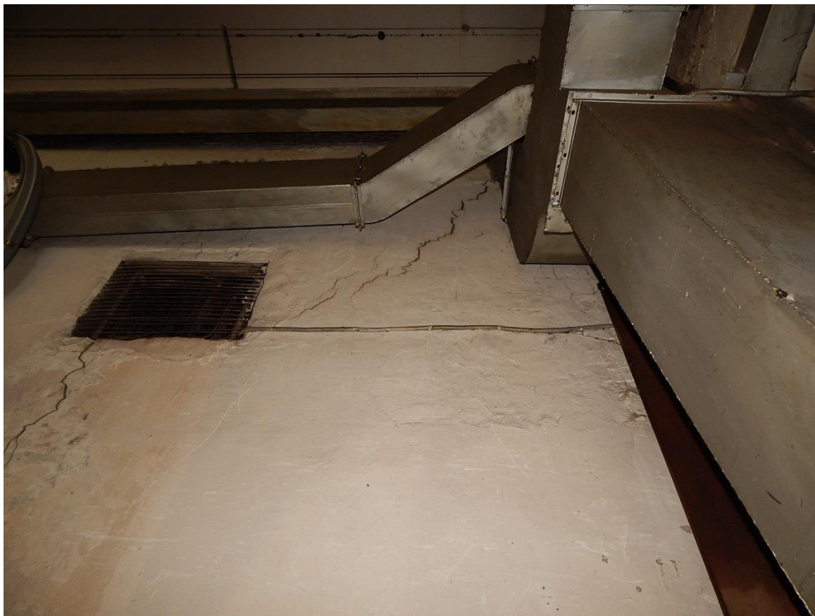
Рис. 3.1.28. Трещина №19 шириной раскрытия до 15 мм (вид из гаража)
