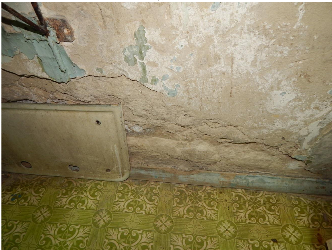
Рис. 3.1.43. Дефект в виде локального разрушения штукатурного слоя внутренней отделки стен
