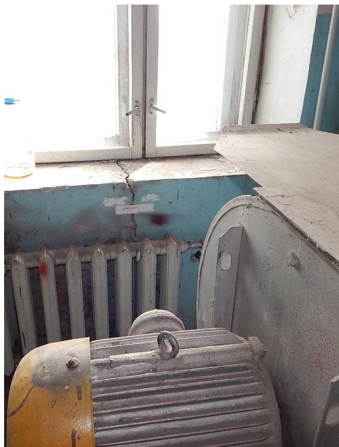
Рис. 3.1.17. Трещина №14 шириной раскрытия до 12 мм (вид изнутри)
