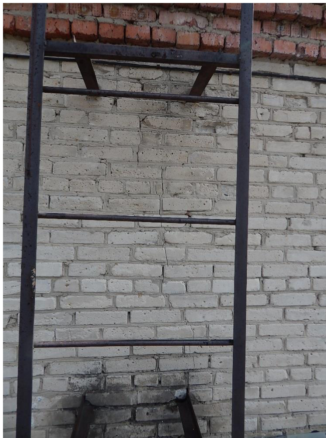
Рис. 3.1.14. Трещина №11 шириной раскрытия до 1 мм (вид с улицы)
