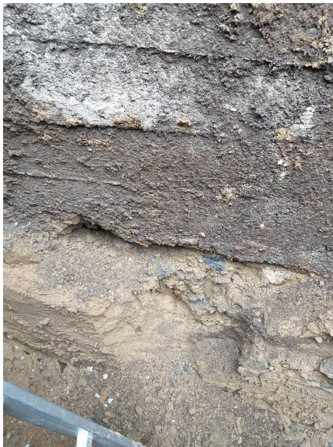
Рис. 3.7.15. По нижнему обрезу фундамента не предусмотрено уширение подошвы (шурф №3)
