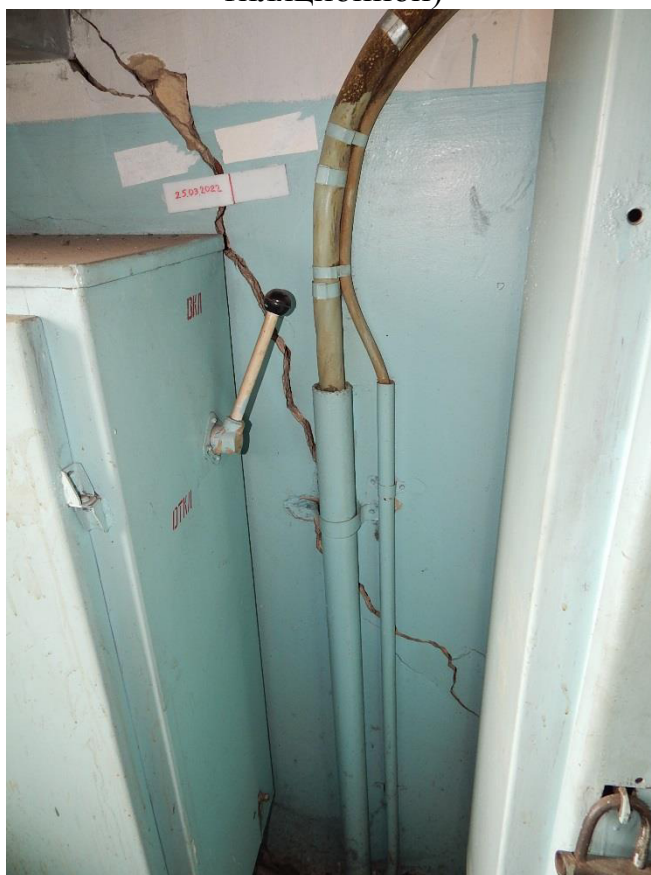
Рис. 3.1.25. Трещина №19 шириной раскрытия до 15 мм (вид из помещения вентиляционной)
