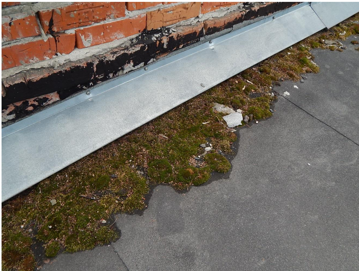
Рис. 3.3.11. Выявлено образование мха на участке примыкания гидроизоляционного кровельного ковра к кирпичному парапету по оси А
