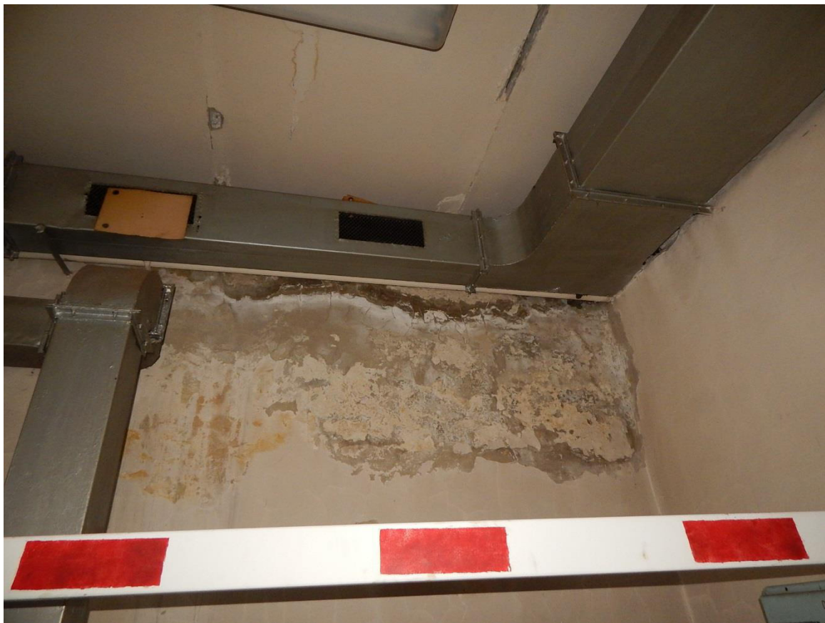
Рис. 3.1.46. Дефект в виде локального разрушения штукатурного слоя внутренней отделки стен
